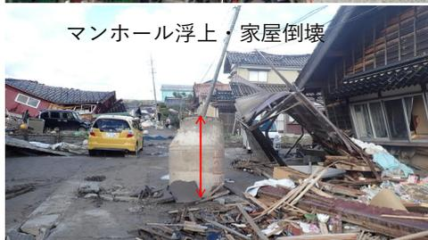
津波避難に使われる道路では、地震により路面は凸凹、マンホールは浮上がり、橋との間には段差が生じた。津波浸水対策＋避難経路確保も課題
