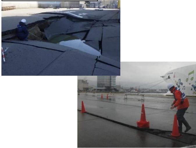
岸壁自体の損傷に加え、岸壁背後の沈下・液状化により支援活動に制限。
