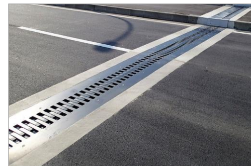
橋の伸縮継手
