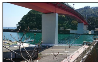
長島港 (橋梁の改良)
