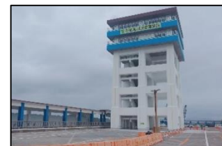
新島港 (津波避難施設の整備)
