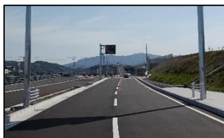
徳島小松島港 (臨港道路の整備)
