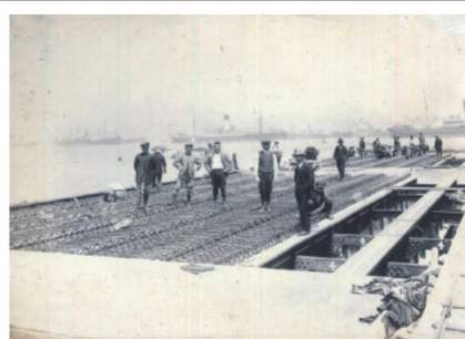
9、10、11号岸壁では、復旧工事の速成のため、横棧橋(陸地に並行に作られる棧橋)方式を採用した、橋 脚にはコンクリートケーソンを使用した
