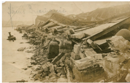
崩壊した新港ふ頭の岸壁 1923(大正12)年 係船柱(ポラード)の位置から、岸壁が倒れたことが わかる。上屋は完全に倒壊している
