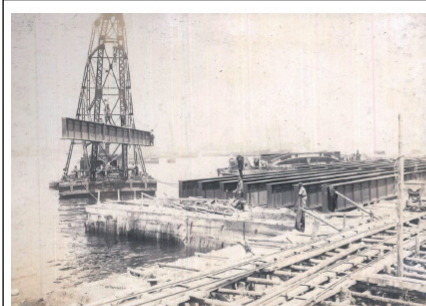
9、10、11号岸壁では、復旧工事の速成のため、横棧橋(陸地に並行に作られる棧橋)方式を採用した、橋 脚にはコンクリートケーソンを使用した
