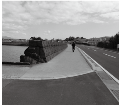
宮ヶ浜海岸道路護岸
