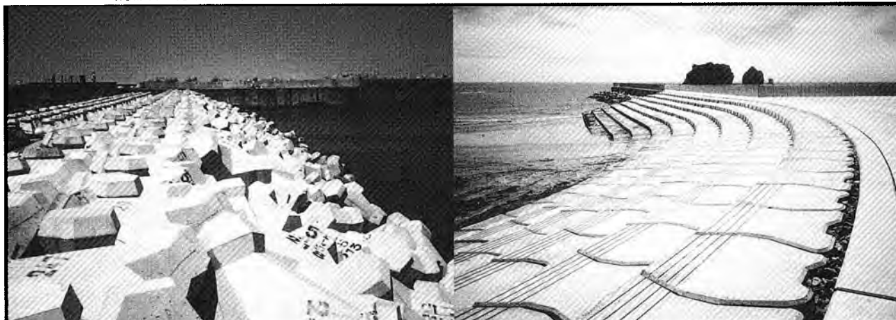
消波・根固ブロック クリンガー
