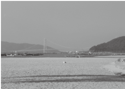
明石海峡大橋を望む
