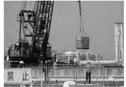
ガット船のクレーンを使った荷役作業
