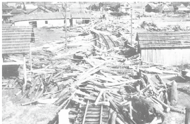
写真1 昭和南海地震津波時の木材流出状況
