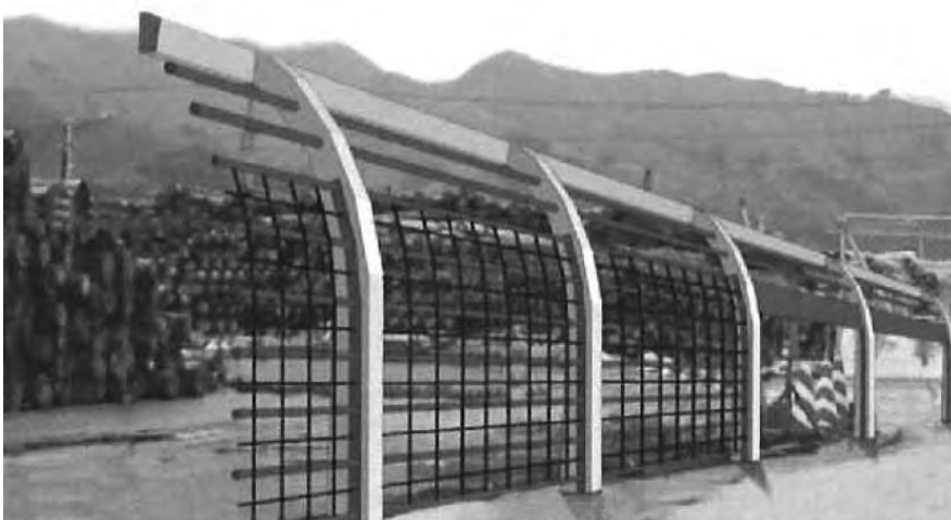
図2 津波漂流物捕捉施設(イメージ)
