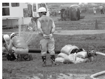
水道管応急復旧訓練
