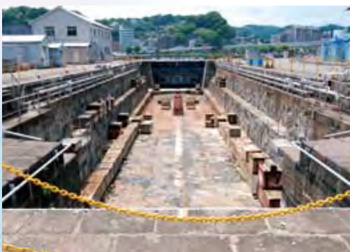
並木喜久雄 神奈川県横須賀港 ドライドック
