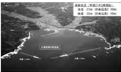
整備が進められている久慈港湾口防波堤
