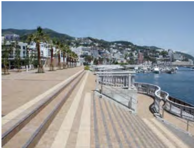
完成したテラス型堤防(渚第3工区)
