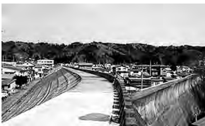
S 33.3 に町を囲む様に完成した大防潮堤 (旧田老町)
