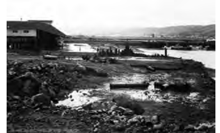
十勝沖地震津波の跡
