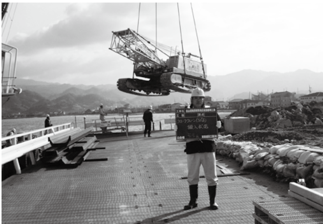
仮設栈橋からの資材搬入の様子
