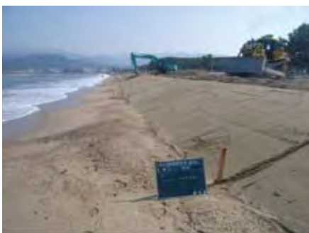
盛土養浜状況
