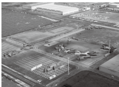
写真-1 コンテナ散乱状況 (海上保安庁提供)
