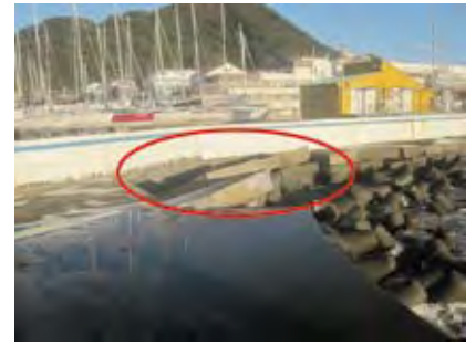
神奈川県葉山港 防波護岸
