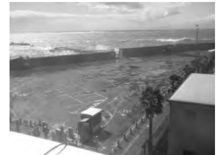
被災後 (平成 21 年 10 月 8 日)
