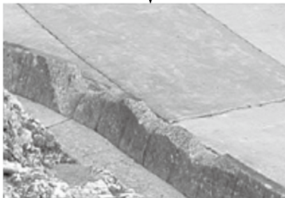
巨石が打ち上げられる際に衝突し破損したと想定される待受擁壁部
