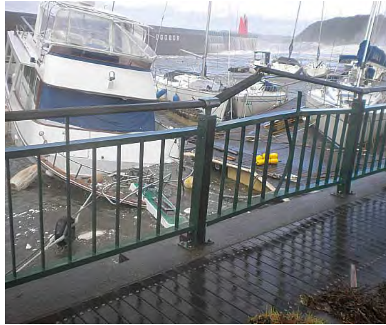
被災後 (平成 21 年 10 月 10 日)
