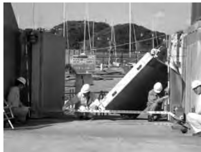
被災後 (平成 21 年 10 月 10 日)
