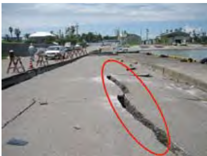
静岡県 相良港 物揚場
