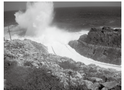
台風の強風域の時点での南大東港亀池地区の状況 (岸壁に当たった波が臨港道路に溯上)
