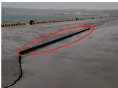
静岡県 御前崎港 岸壁
