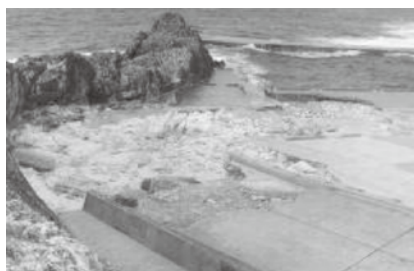
巨石が打ち上げられる際に衝突し破損したと想定される待受擁壁部
