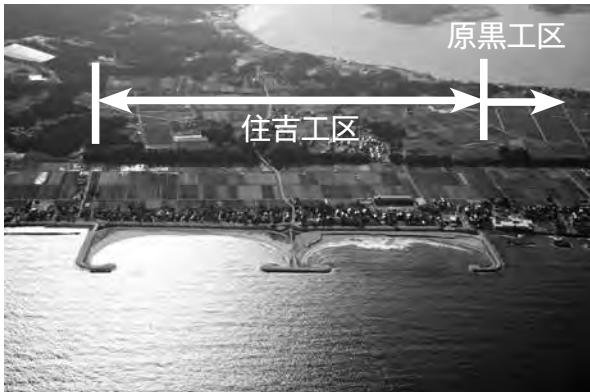
写真-6 両津港海岸(住吉工区)の航空写真(平成21年)
