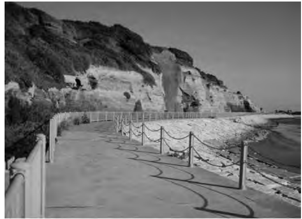
写真3 完成した遊歩道(平成22年夏)
