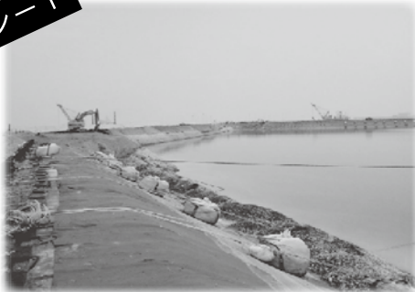
緩衝機能付安全柵
