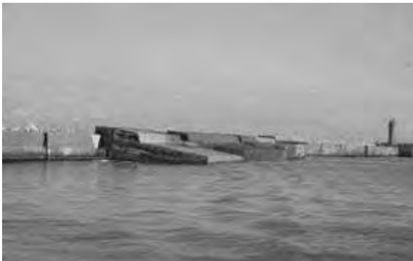
写真2-1 北防波堤被災状況
