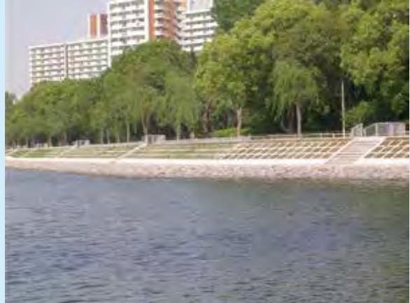
品川区京浜運河緩傾斜防潮堤
