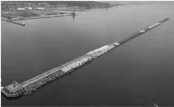
写真3-1 北防波堤復旧工事完成状況
