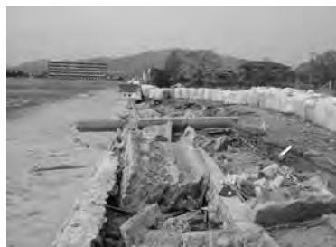
写真-12 応急仮工事
