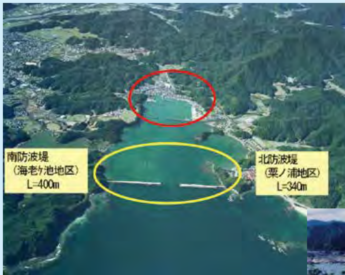
浅川港津波防波堤
