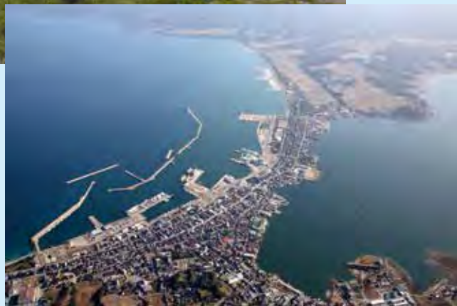
両津港全景（平成21年）
