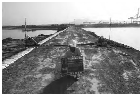
写真-7 アイランドシティ埋立護岸復旧完了
