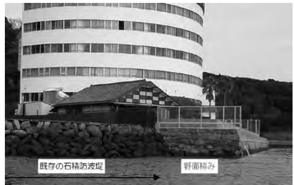
写真7 終点部整備後状況
