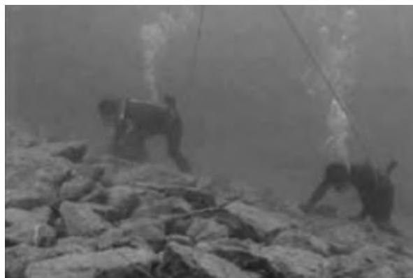
写真2 施設の潜水調査
