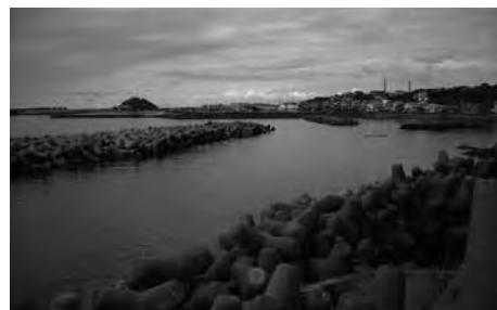
国道228号線沿い整備した離岸堤と嵩上げた護岸
