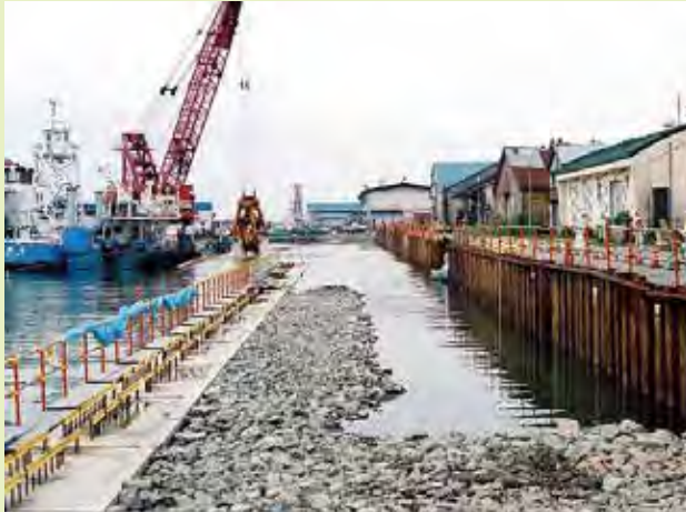
漁港区第4物揚場 復旧状況
