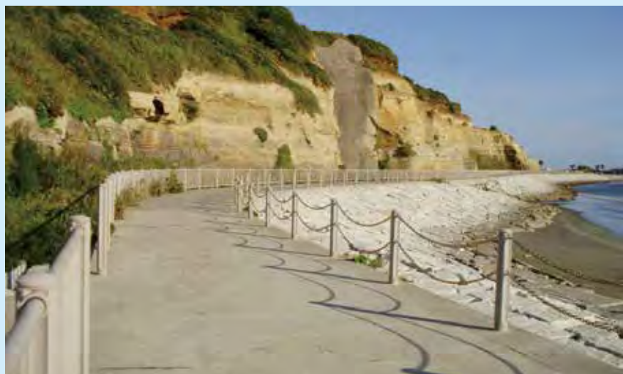
完成した遊歩道（平成22年夏）
