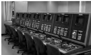
津波防災ステーション
