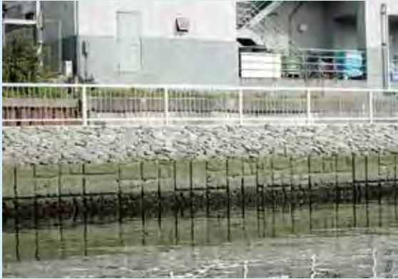
耐震護岸整備状況
