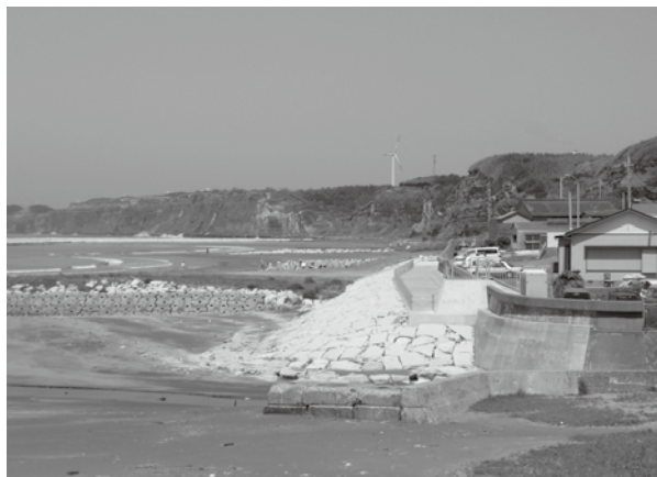
写真2 施工中の名洗港海岸
