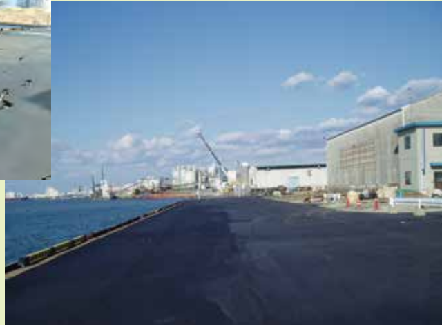
中央ふ頭北ー 5.5m岸壁復旧完了
