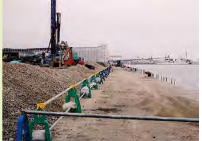
第2ふ頭第1岸壁 復旧状況
