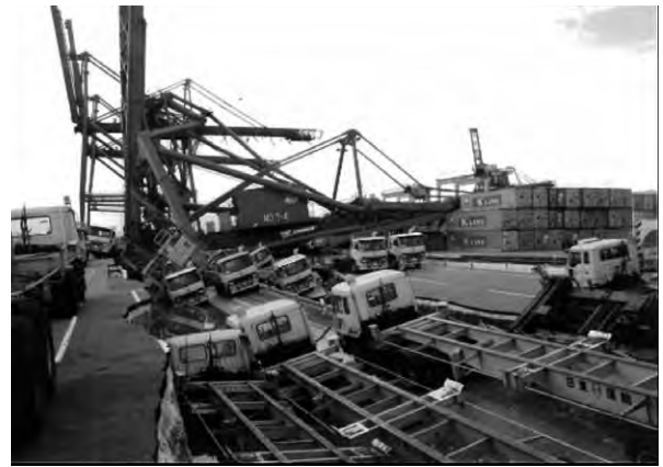
写真1 阪神・淡路大震災時のコンテナターミナルの被災状況 (国土交通省近畿地方整備局神戸港湾事務所撮影)
