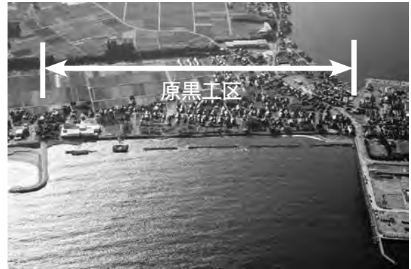
写真-8 両津港海岸(原黒工区)の航空写真(平成21年)
