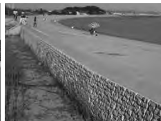
化粧型枠を用いた胸壁
