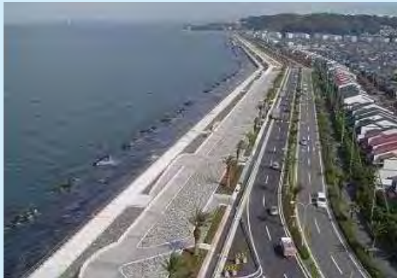
完成した改良護岸全景
