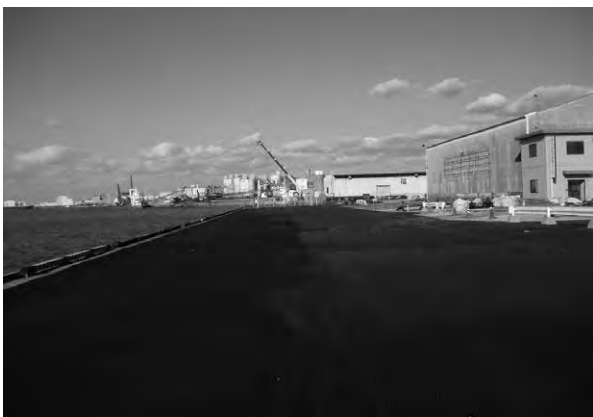
写真-9 中央ふ頭北-5.5m岸壁復旧完了
