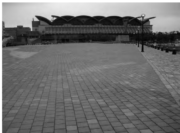
写真-11 中央ふ頭イベントパース復旧完了
