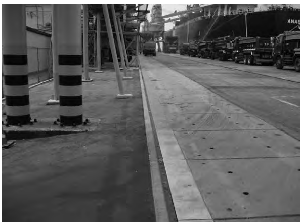
写真-10 須崎ふ頭-11.0m岸壁復旧完了
