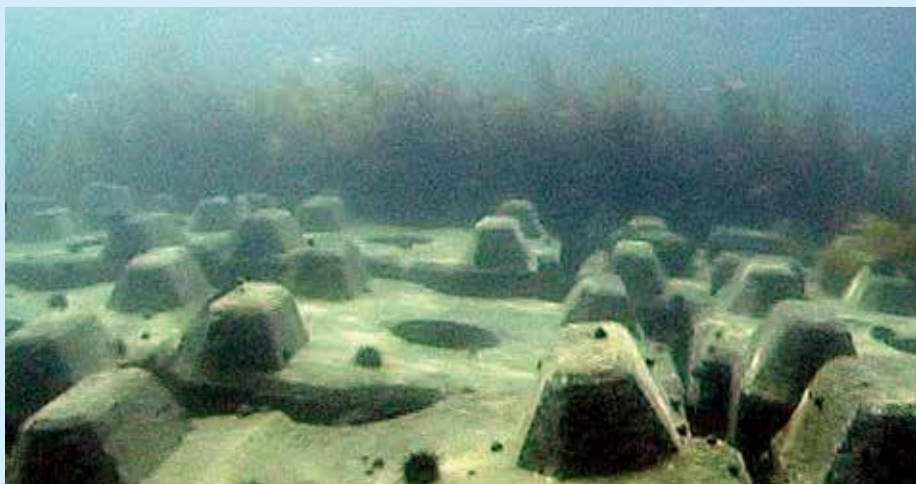
前方：普通ブロック、後方：エコサンドパネル付ブロック
