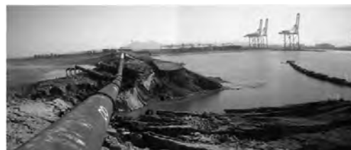
写真-2 箱崎ふ頭 北-7.5m岸壁(法 線のはらみ出し状 況)
