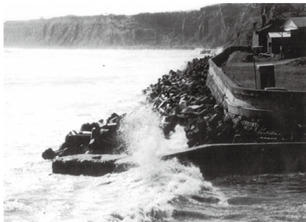
写真1 施工前の名洗港海岸
