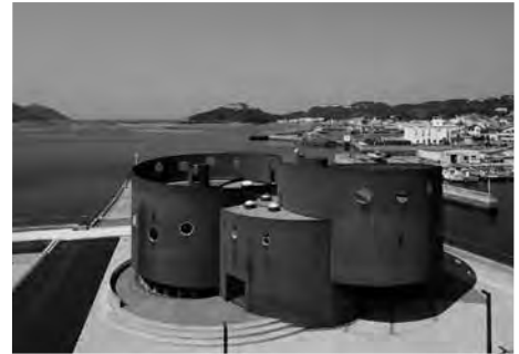
福良港津波防災ステーション
