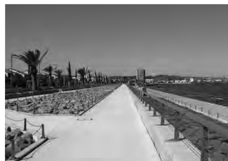
高潮対策事業により整備された馬堀地区
