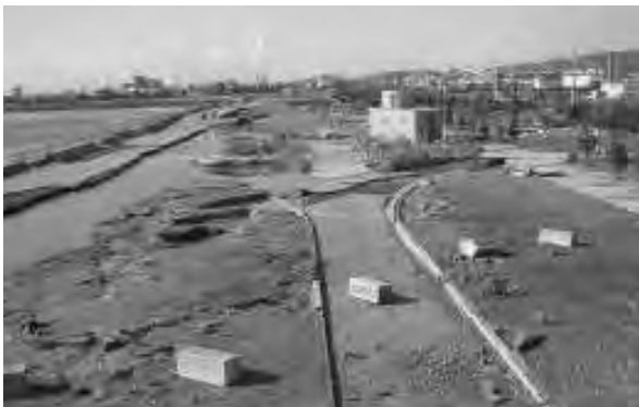
写2-2 万葉ふ頭被災状況
