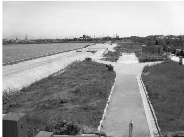
写真3-2 万葉ふ頭復旧工事完成状況
