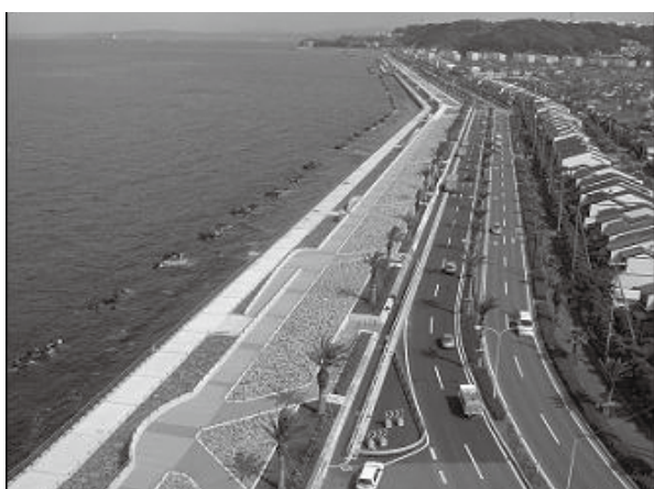
写真1 完成した改良護岸全景
