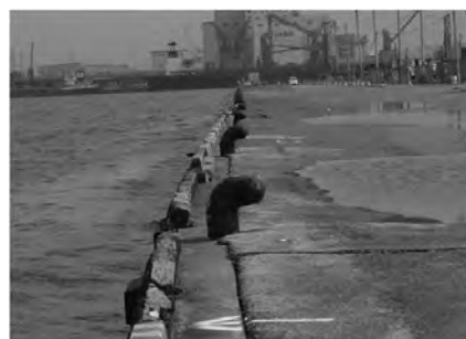
写真-2 箱崎ふ頭 北-7.5m岸壁(法 線のはらみ出し状 況)
