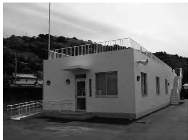
図-7 完成した奈半利町海浜センター
