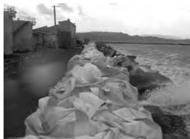
写真-9 応急仮工事
