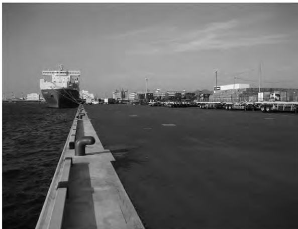
写真-8 箱崎ふ頭北-7.5m岸壁復旧完了
