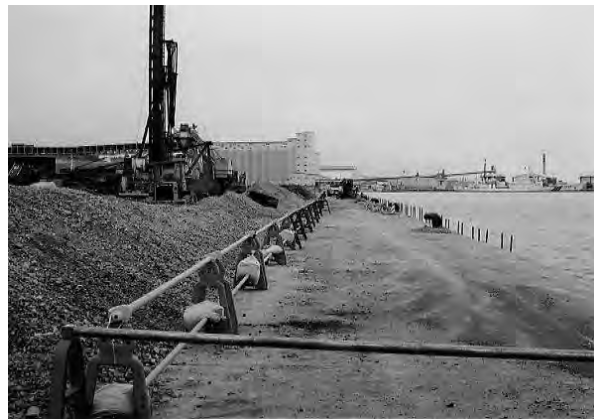
写真6 第2ふ頭第1岸壁 復旧状況
