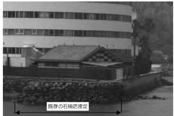
写真6 終点部整備前状況
