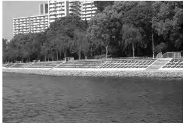
図-4 品川区京浜運河緩傾斜防潮堤
