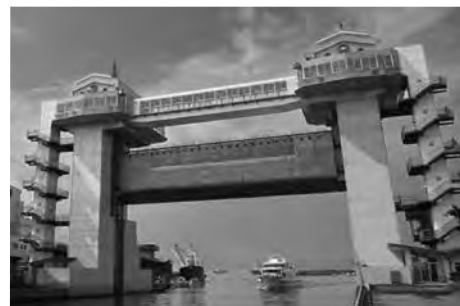
沼津港海岸 高潮対策事業 船路水門「びゅうお」
