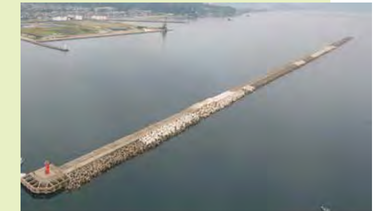
北防波堤復旧工事完成状況
