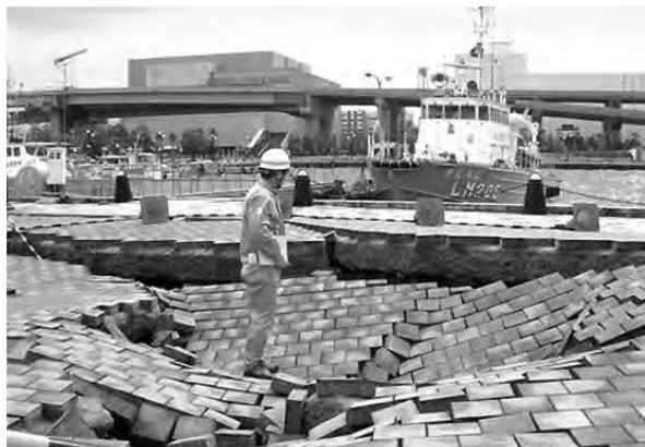
写真-6 中央ふ頭イベントバース (陥没状況)
