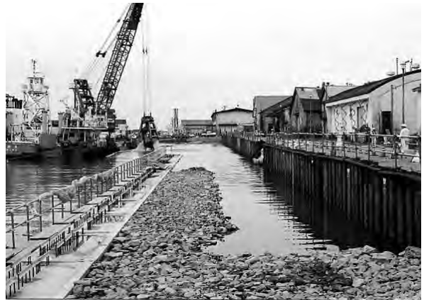
写真5 漁港区第4物揚場 復旧状況
