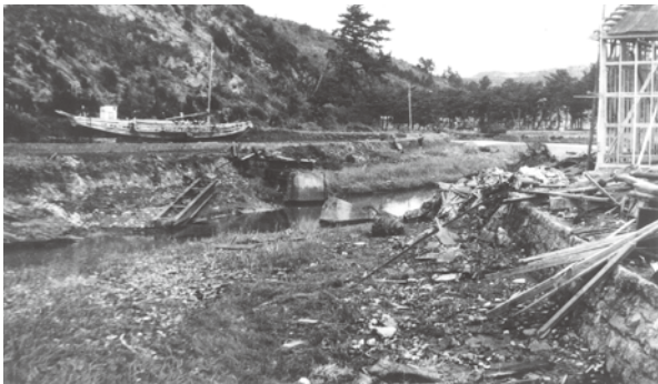
図-2 江上川河口付近の津波被害(昭和南海地震津波)
