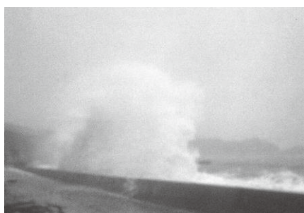
写真2 和気地区越波状況
