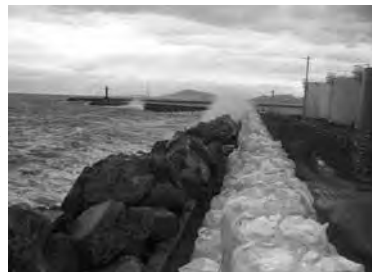
写真-6 応急仮工事
