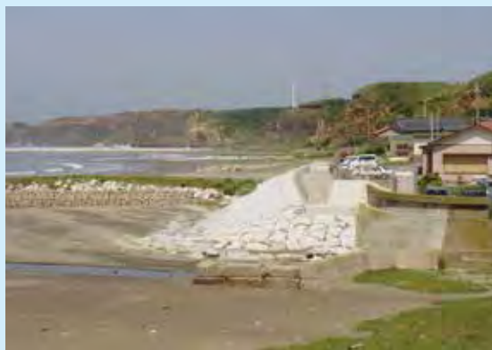
施工中の名洗港海岸
