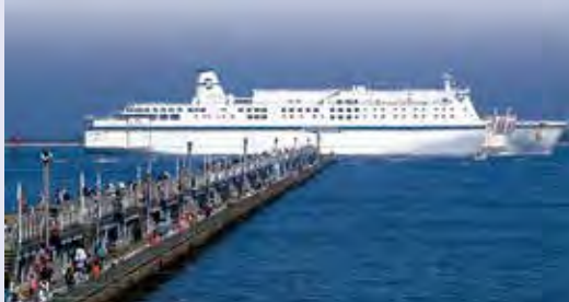
名古屋港海づり公園（高潮防波堤）
