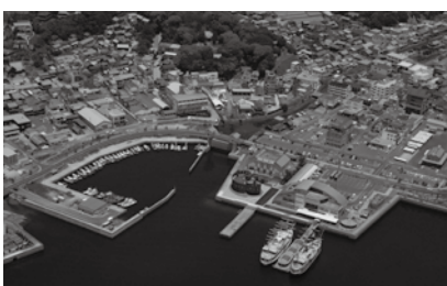
津波防災ステーション周辺
