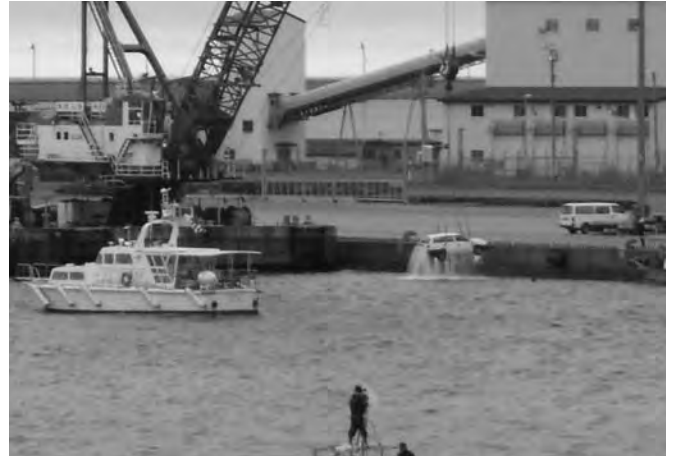
海中転落車両の除去作業 (海上訓練エリア)
