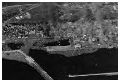
写真4 青苗地区での被害の様子
