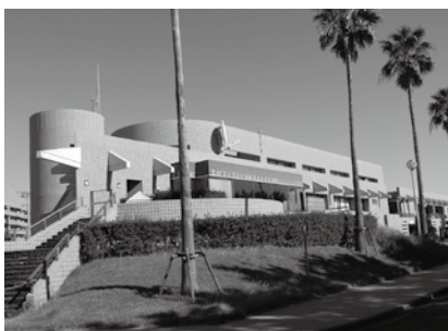
なぎさギャラリー (藤沢土木事務所・汐見台庁舎)
