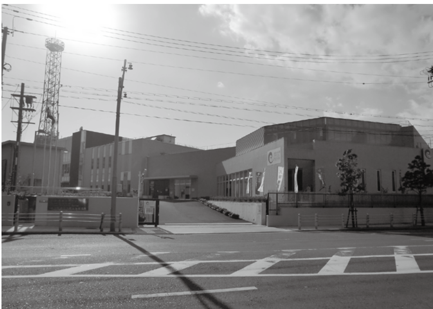
津波・高潮ステーション
