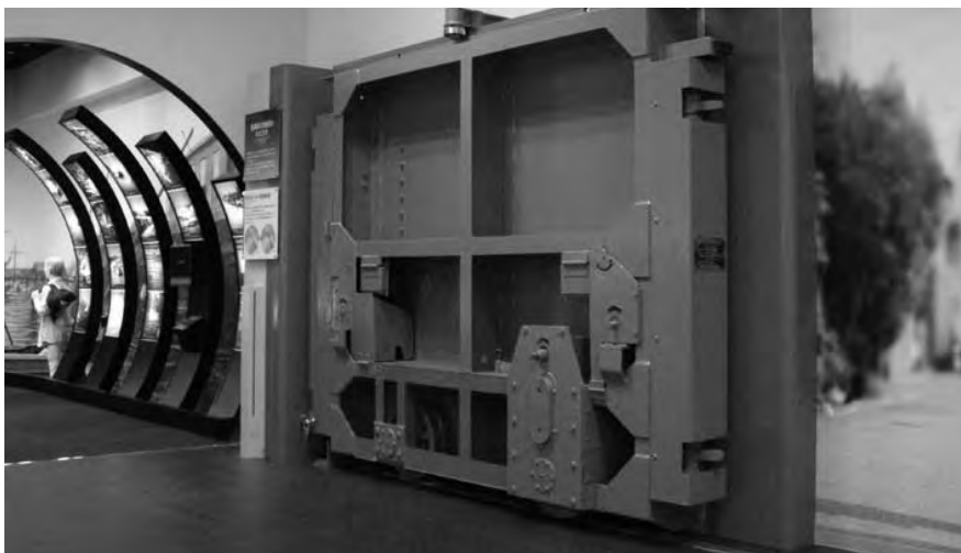
承のコーナー 防潮扉(鉄扉)
