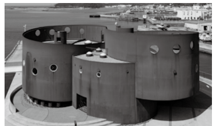
津波防災ステーション
