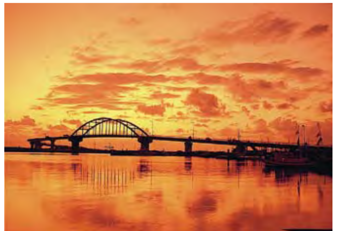
石垣港サザンゲートブリッジ
