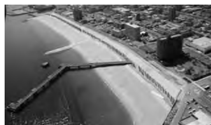
餅ヶ浜地区全景 平成22年3月撮影
