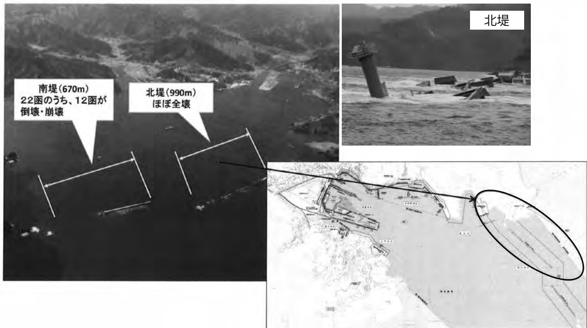
写真1(2) 港湾施設の被災状況
