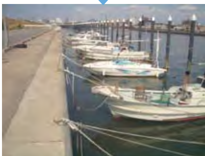
写真-1 係留保管施設の整備
