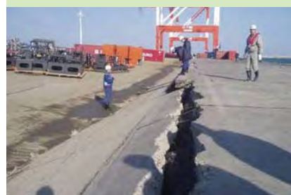
液状化による段差の発生(茨城港常陸那珂港区)
