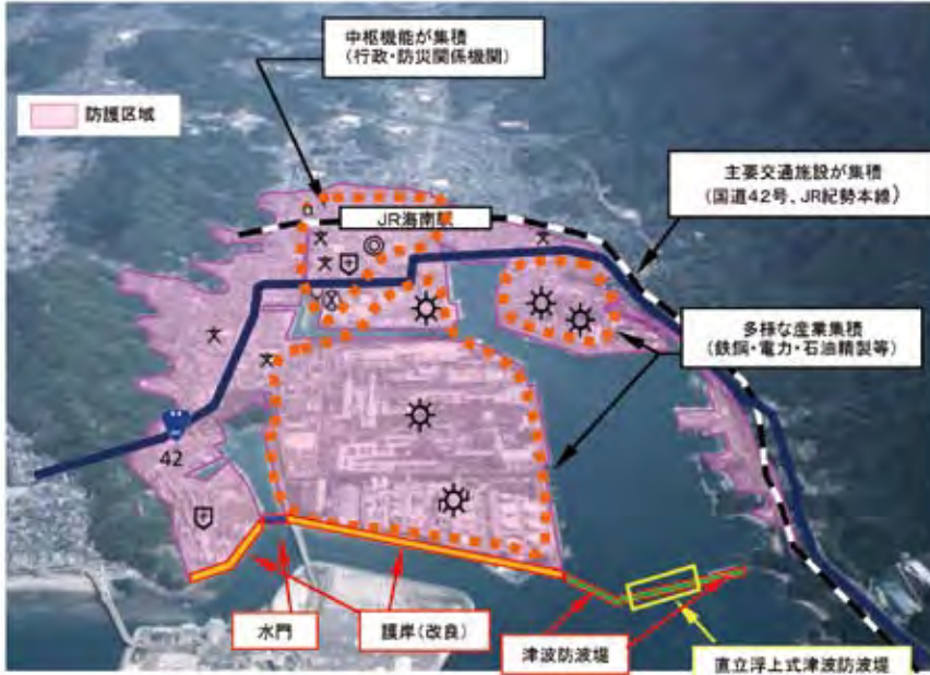
和歌山下津港海岸（海南地区）
