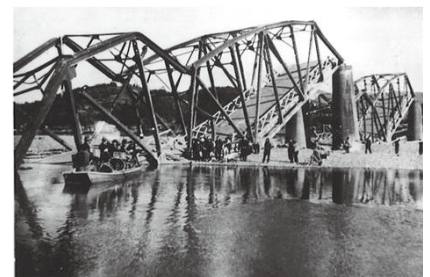
中村市（現四万十市）昭和南海被災（赤鉄橋）
