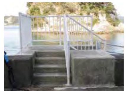
写真-2 コンクリートによる陸間の閉塞
