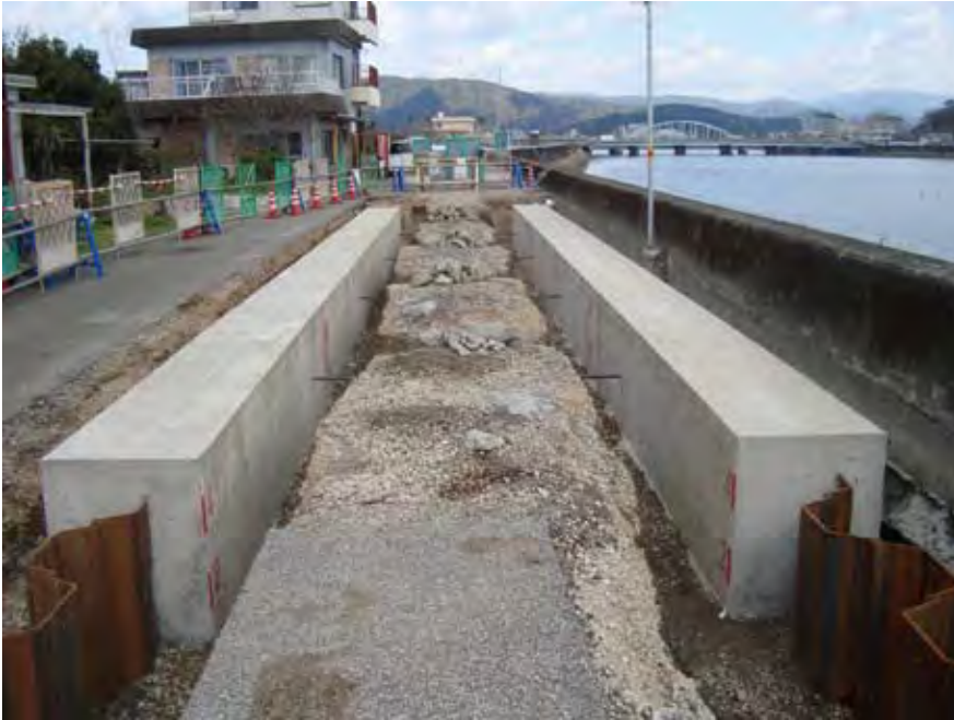
液状化対策工事（国分川）
