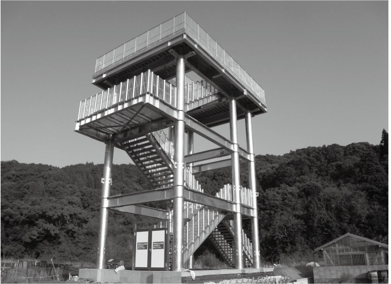
津波避難タワー（四万十町）
