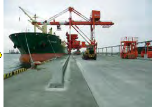
復旧後 (平成 25 年 7 月撮影) ※荷役機械も新替しました。
