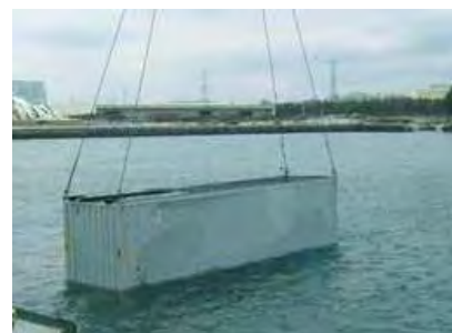
写真1 航路の啓開状況
