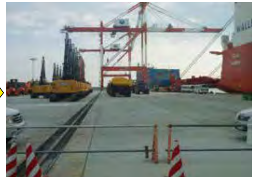
復旧後 (平成 24 年 11 月撮影)
