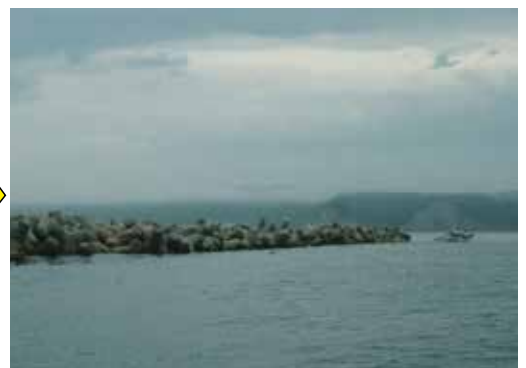
復旧後(平成25年6月撮影)
