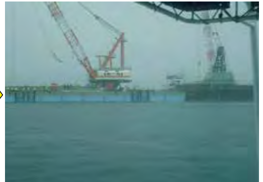
復旧工事中 (平成 25 年 6 月撮影)
