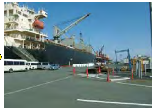
復旧後(平成24年6月撮影)
