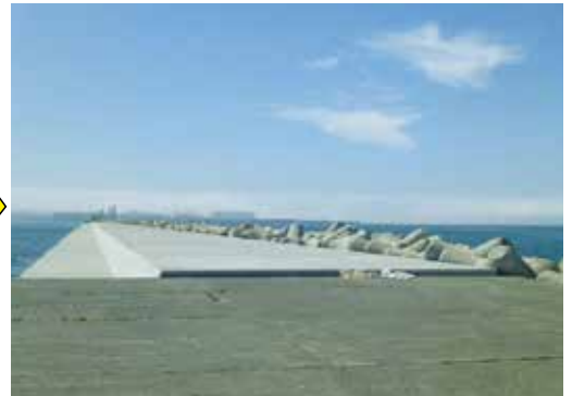
復旧後(平成25年6月撮影)
