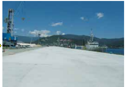
復旧後 (平成 25 年 6 月撮影)
