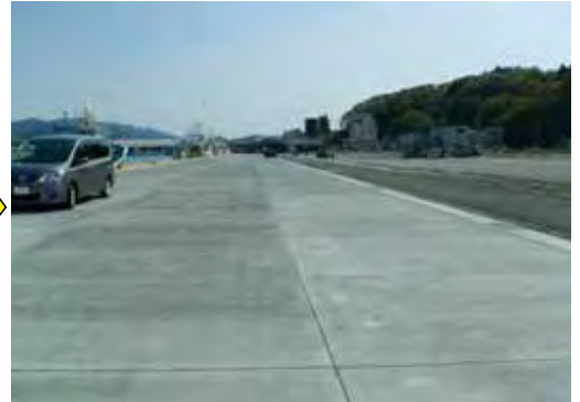
復旧後 (平成 25 年 3 月撮影)
