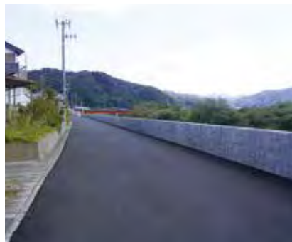
(写真-6) 完成直後
