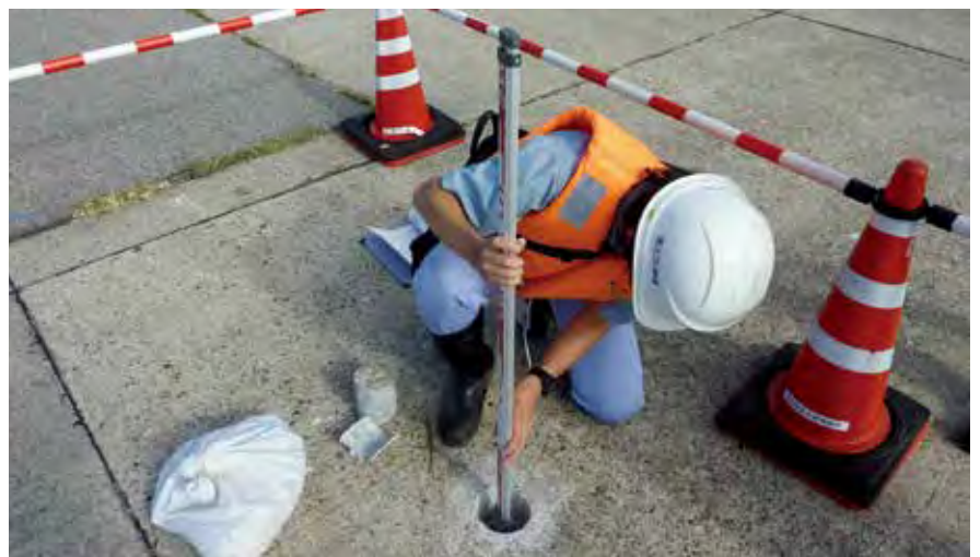
エプロン下の空洞調査の例
