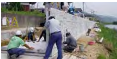
(写真-2) 製品施工
