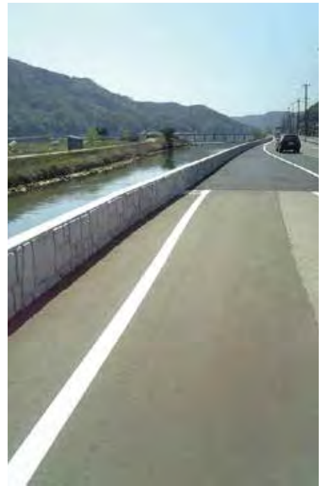
(写真-7) 完成供用中
