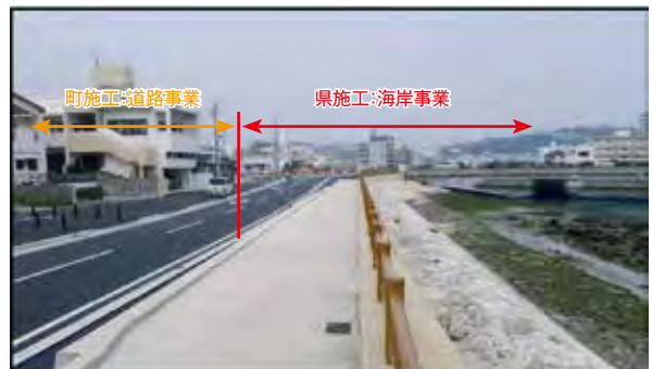
整備後：石積式護岸及び町道整備
