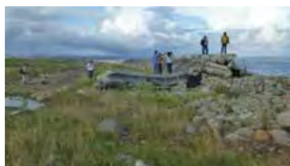
図8 タクロバン空港護岸の破壊
