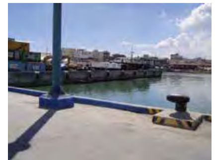
図 5 エプロンに乗り上げた船と周辺の岸壁
