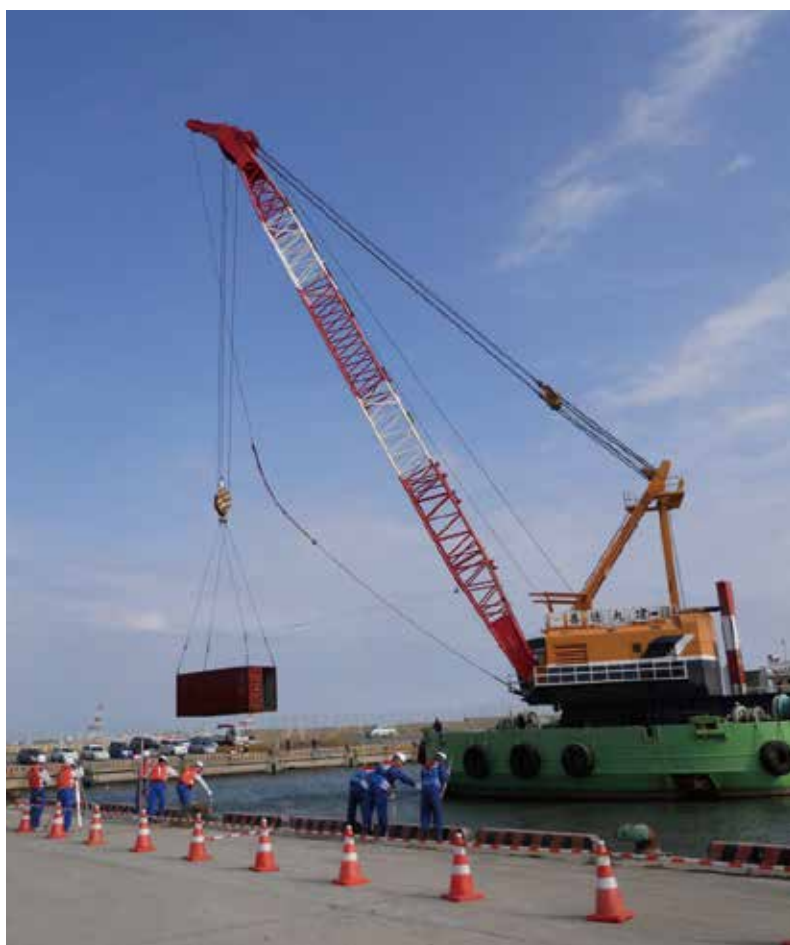
航路啓開訓練におけるコンテナ揚収作業
