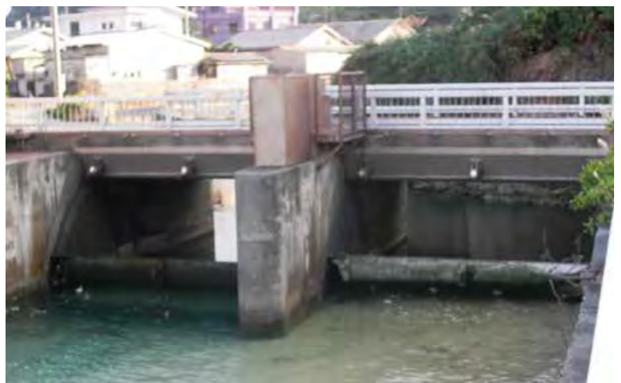
祖納地区・田原川水門
