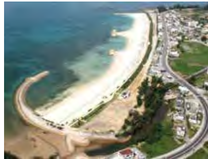
屋嘉地区(整備後)
