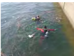
ダイバーの作業状況
