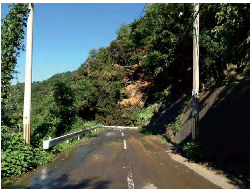
写真-1 遊子地区の崩れた土砂と木が道路を塞いでいる状況
