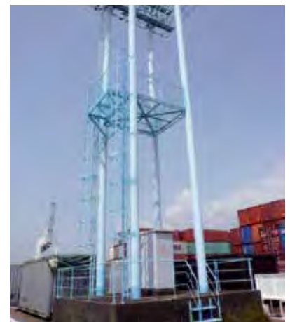
図-2 静岡県清水港の既設照明塔に踊り場を 設置(写真:静岡県提供)
