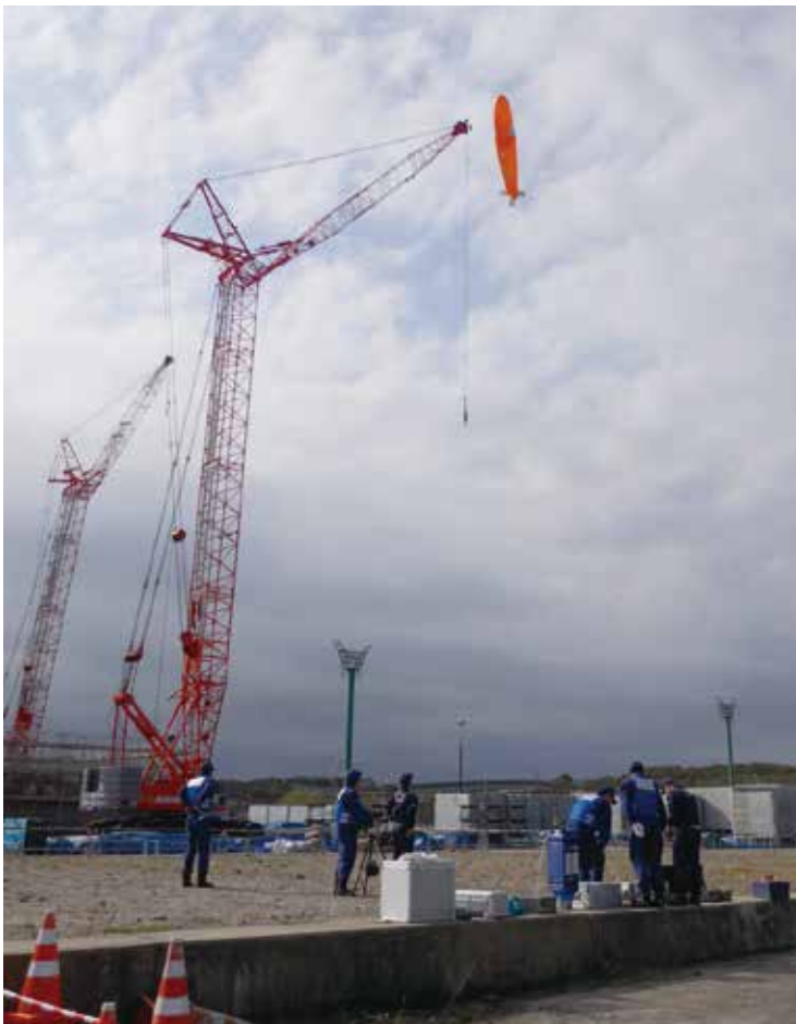
気球空撮システムによる港湾被災調査
