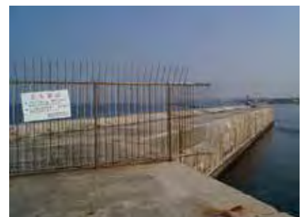
富具崎港立入禁止柵
