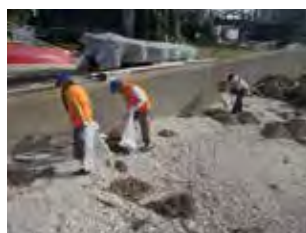
河和港清掃状況
