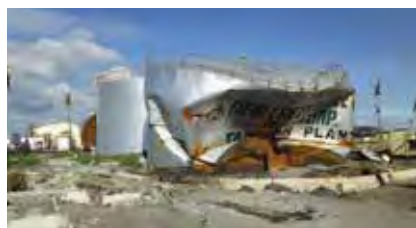
図9 タナワンの精油所のタンクの被災
