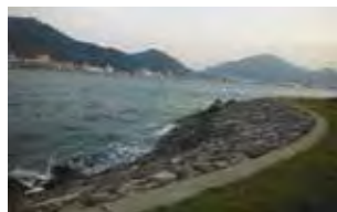
親水性の高い緩傾斜護岸
