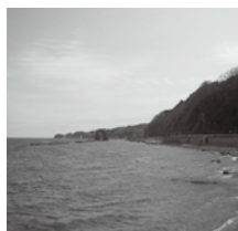
奥尻港海岸現況写真
