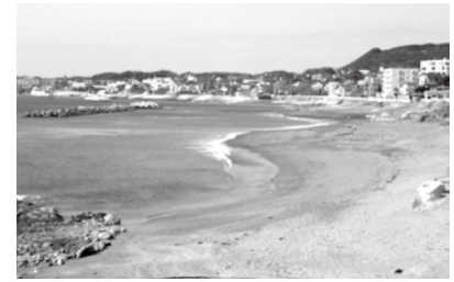
離岸堤とトンボロ現象
