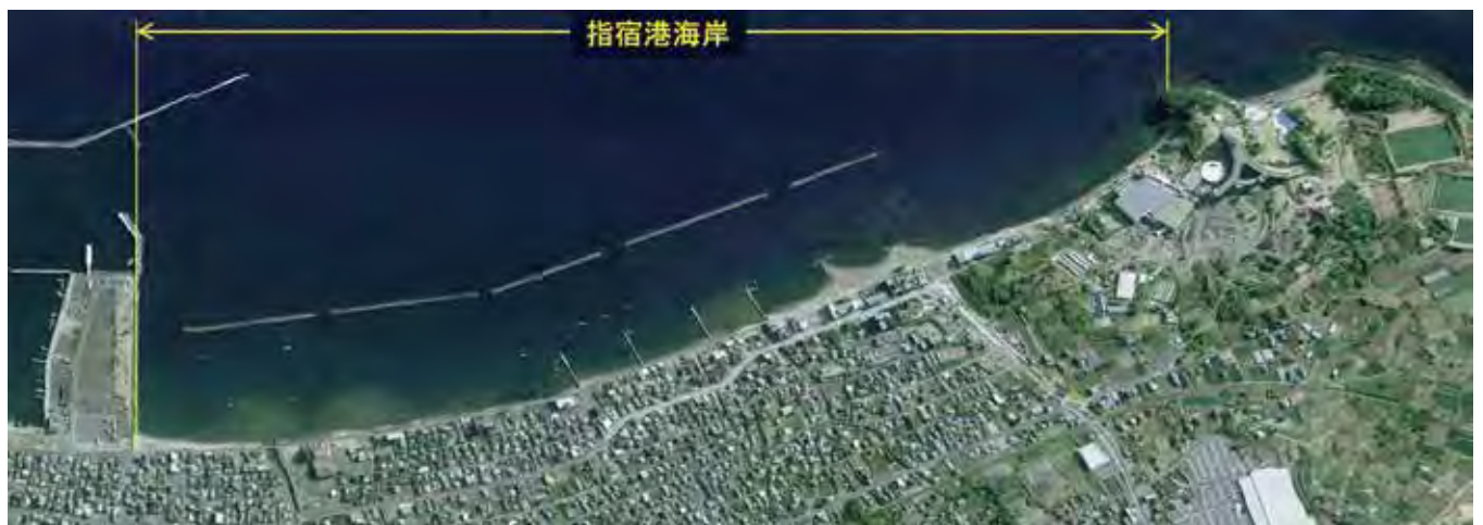
写真-3 現在の指宿港海岸。これまでに、突堤、離岸堤などが整備されている。
