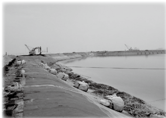
【遮水シート：管理型廃棄物海面処分場】
