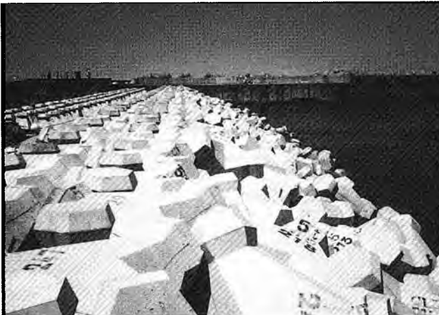
消波・根固ブロック クリンガー
