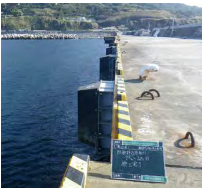
写真-4.1 鋼製台座設置
