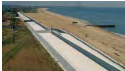
栗真町屋工区(平成25年度完成箇所)
