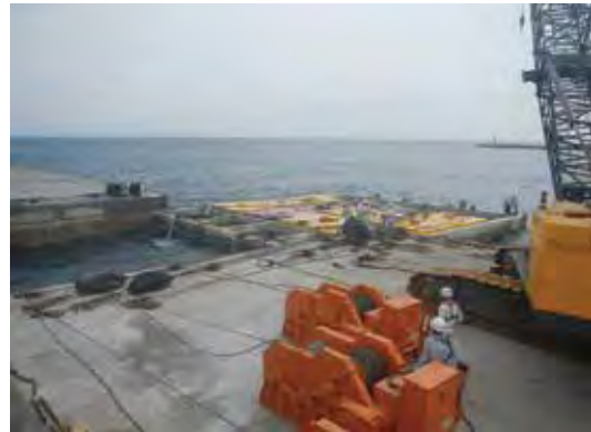
写真-4.4 ケーソン据付準備
