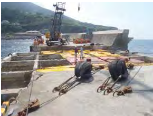
写真-4.5 ケーソン据付
