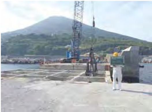
写真-4.3 中詰材撤去
