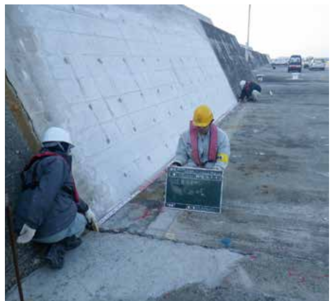
写真-4.2 岸壁(-6.0m) 4函目パラペット復旧
