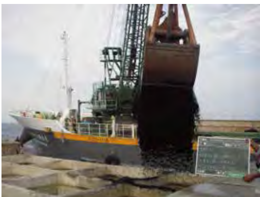
写真-4.7 中詰材投入
