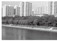
京浜運河 防潮堤(品川区 八潮)
