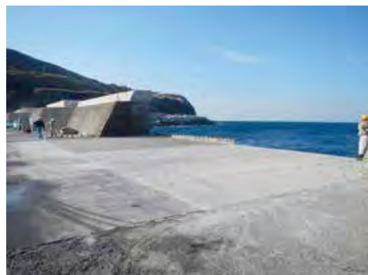
写真-4.8 上部コンクリート打設
