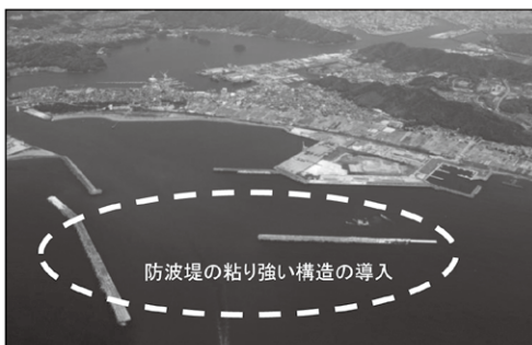
粘り強い構造の防波堤整備事例：高知港
