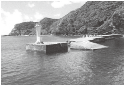
沖縄県 渡嘉敷港 防波堤(南)
