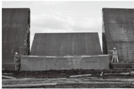
長崎県 峰港 護岸(防波)
