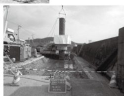
鋼管杭施工状況(若松工区)
