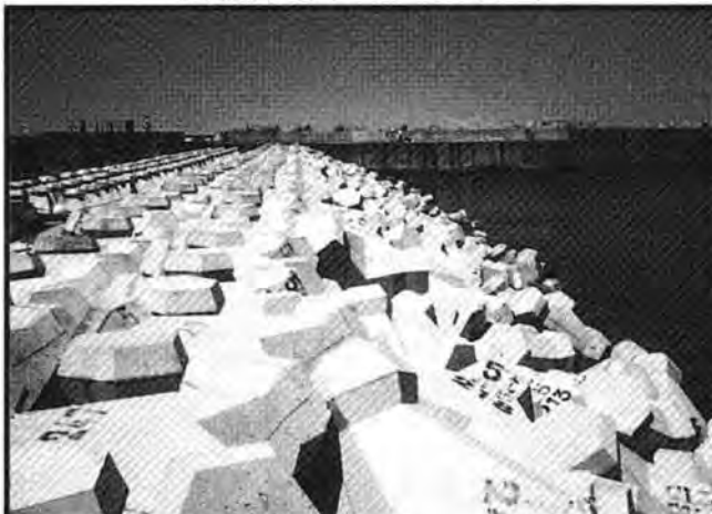
消波・根固ブロック クリンガー
