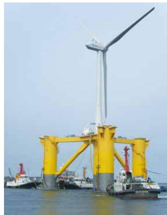
浮体式洋上ウインドファーム
