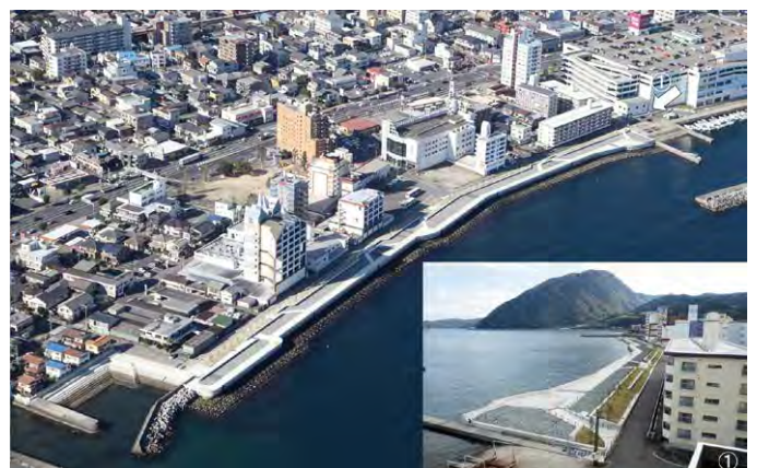
写真-7 北浜地区1の整備後
