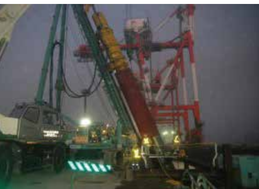
写真2 昼夜兼行の復旧工事状況 (高砂2号岸壁)
