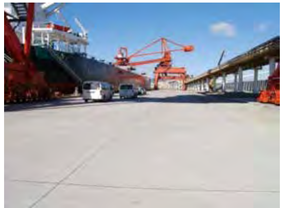
復旧後の6号ふ頭
