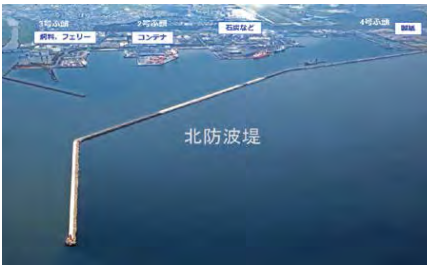
災害復旧事業が完了した北防波堤
