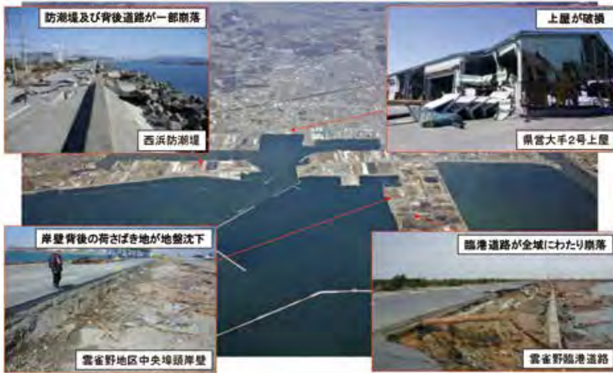
写真4 石巻港区の被災状況
