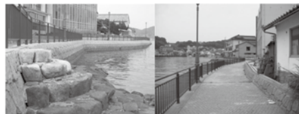
殿ノ浦地区(完了区間)
