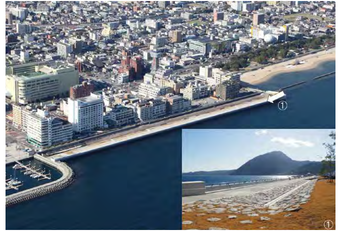
写真-10 北浜地区2の整備後
