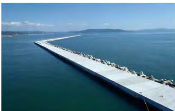
写真5 災害復旧が完了した南防波堤
