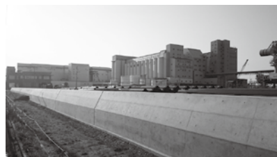
石巻港防潮堤
