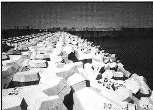
消波・根固ブロック クリンガー
