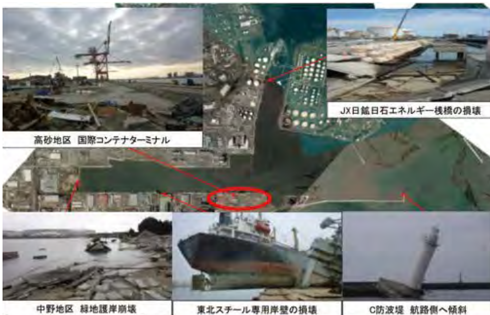
写真1 仙台港区の被災状況
