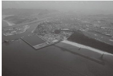
鳥取港海岸西浜地区と背後地の状況
