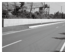
八太郎4号埠頭 防潮堤
