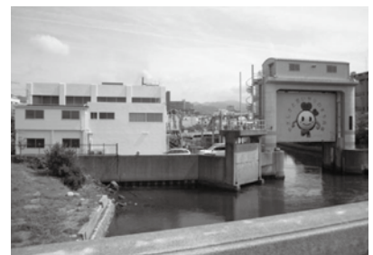
大輪田ポンプ場と水門
