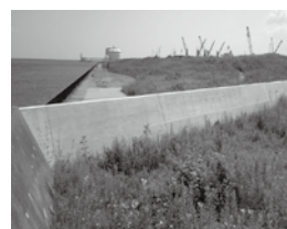
河原木2号埠頭緑地 防潮堤
