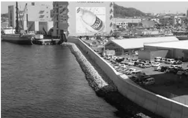
図-3 堤防の嵩上げ状況(撫養港海岸)
