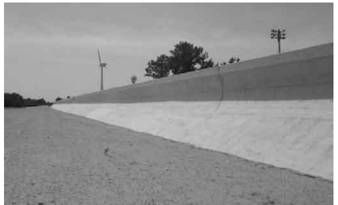
図-4 堤防の嵩上げ状況(津松阪港海岸)
