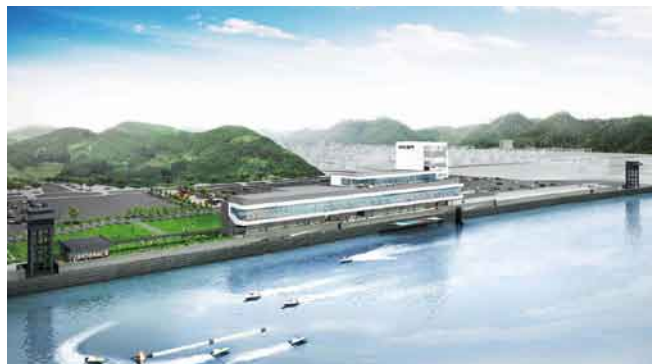
ボートレース鳴門新スタンド
