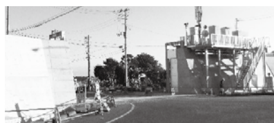
陸間整備状況(施工中)
