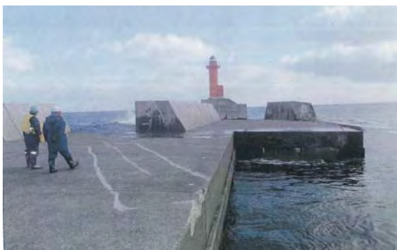
北海道 鷺泊港 防波堤【直轄災】
