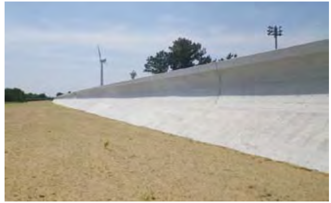
図-3 堤防の嵩上げ状況(津松阪港海岸)
