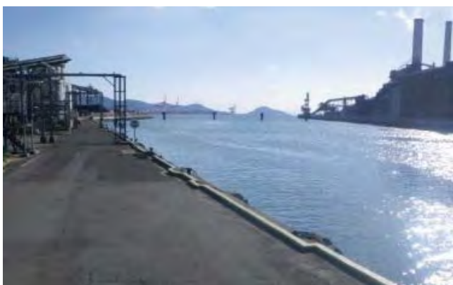
図-4 護岸の嵩上げ前
