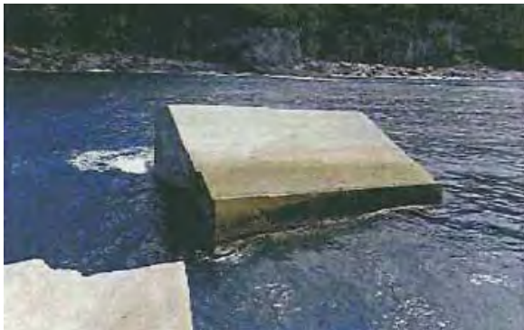
鹿兒島県 片泊港 防波堤【補助災】
