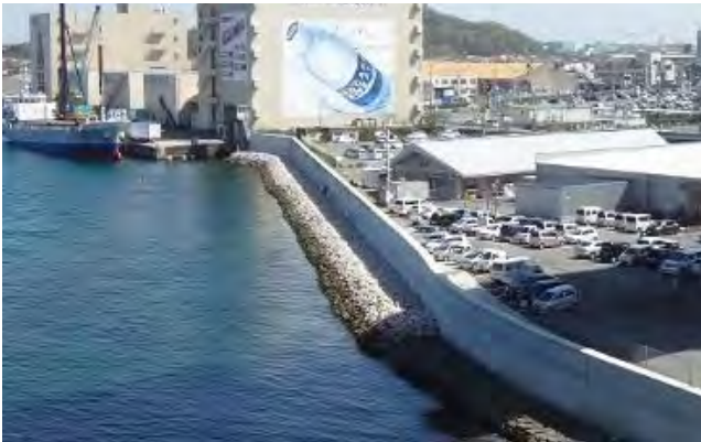
図-2 堤防の嵩上げ状況(撫養港海岸)
