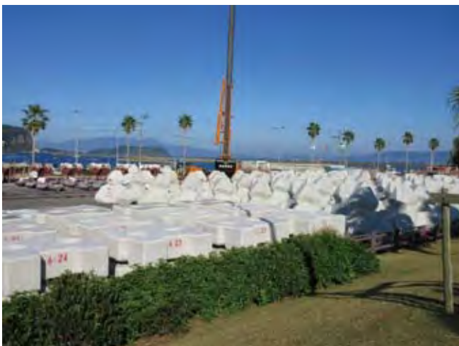
写真-7 ブロック製作
