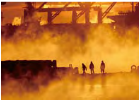
厳冬の朝の築堤現場 吉井 泉 北海道釧路市釧路港(西港)
