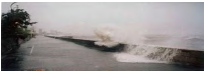
写真-3 平成16年の越波・浸水被害(指宿市提供)
