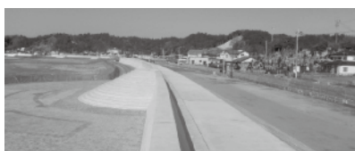
海岸堤防整備状況
