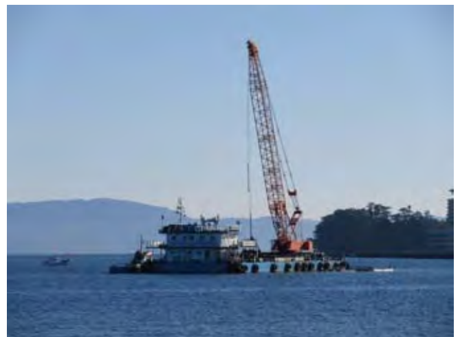
写真-8 捨石マウンド施工
