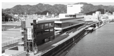
撫養港海岸競艇場前面区間
