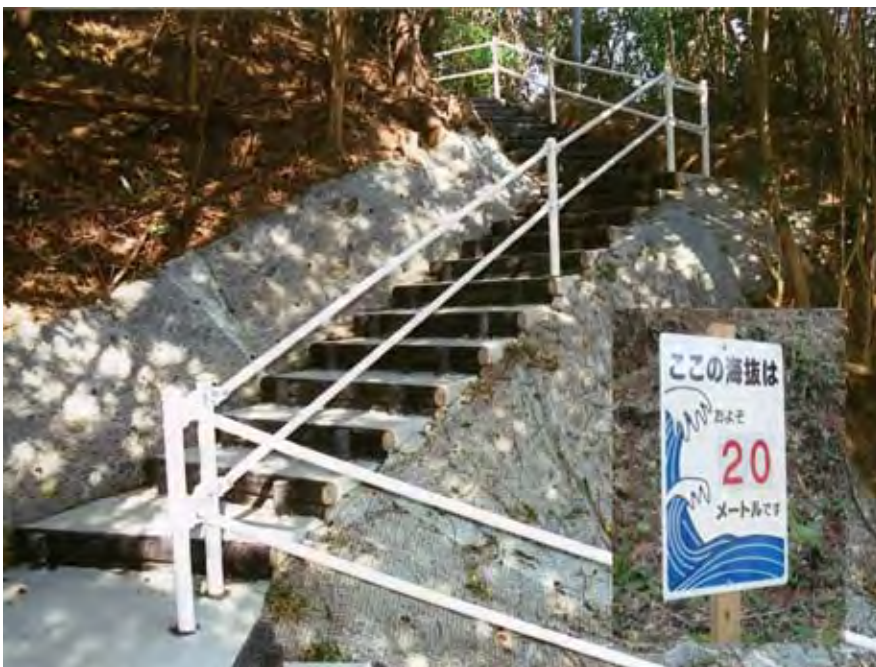
町で整備した津波避難路と海拔表示看板
