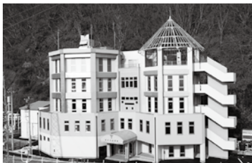
復旧後施設全景
