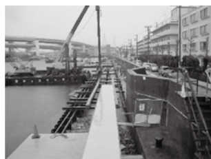
堤防工事の施工状況
