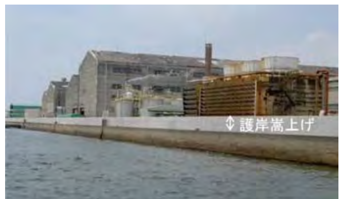
図-4 背後の産業を守る護岸の嵩上げ状況:広島港海岸
