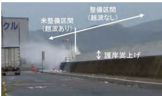
図-3 護岸嵩上げによる防護効果:下関港海岸
