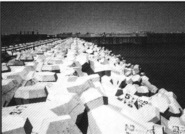
消波・根固ブロック クリンガー
