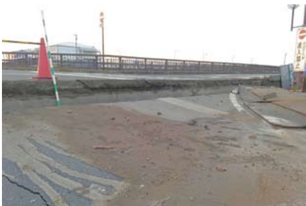
熊本県 熊本港 臨港道路 【補助災】
