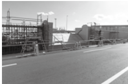
施工状況写真(陸開)
