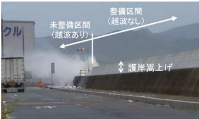
図-2 護岸嵩上げによる防護効果:下関港海岸
