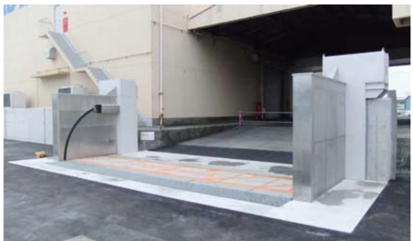
図-5 陸閘の自動化(フラップゲート式):撫養港海岸
