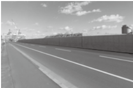
施工状況写真(L型擁壁)
