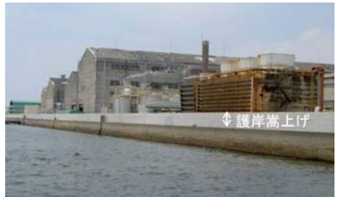
図-3 背後の産業を守る護岸の嵩上げ状況:広島港海岸
