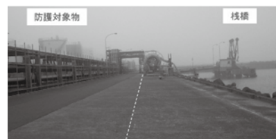
漂流物防護柵 設置箇所
