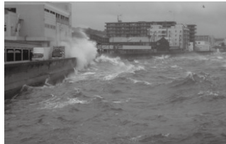
大津地区越波状況
