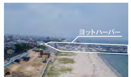
写真-5 H29年度1-1工区整備状況(仮設矢板打設中)(H29.7上旬)
