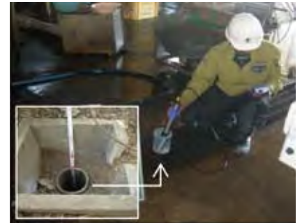
写真-9 井戸の水量、水質確認
