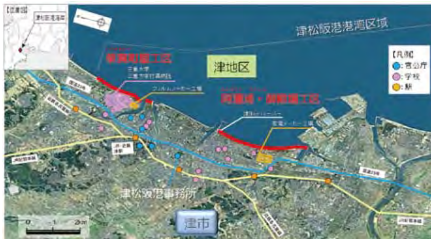
図-1 津松阪港海岸の事業箇所と背後の状況
