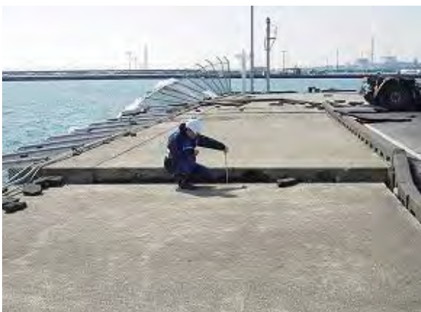
図-2 岸壁の点検状況
