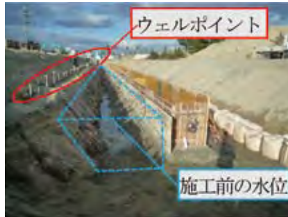
写真-8 基礎部のウェルポイントによる湧水の排水
