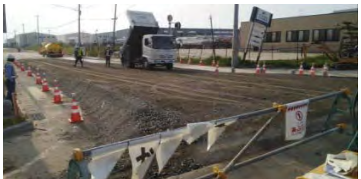
図-3 臨港道路の応急復旧工事
