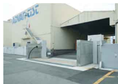
図-11 通常時のフラップゲート式陸開
