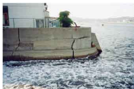
図-2 老朽化が進んでいた既設の堤防
