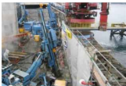
図-8 砂圧入式静的締固め工法※2
