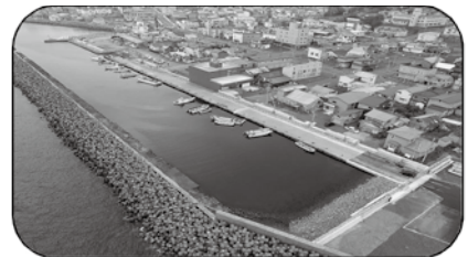
防潮堤の全景
