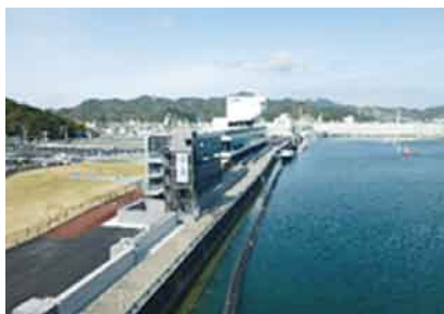
図-10 完成した競艇場区間
