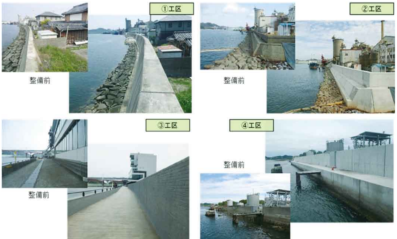
図-14 各工区の整備前後の状況
