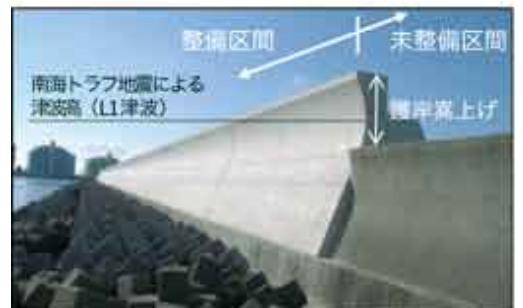
図-3 護岸嵩上げによる防護効果: 和歌山下津港海岸
