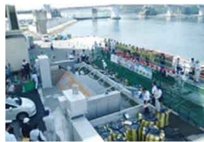
図-12 起動実験中のフラップゲート式陸開
