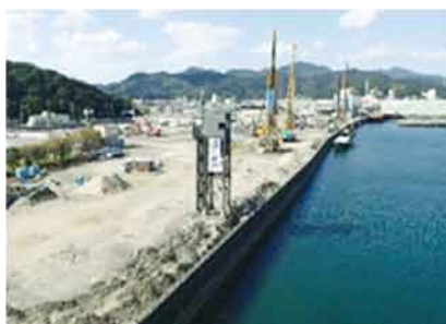
図-9 施工中の競艇場区間
