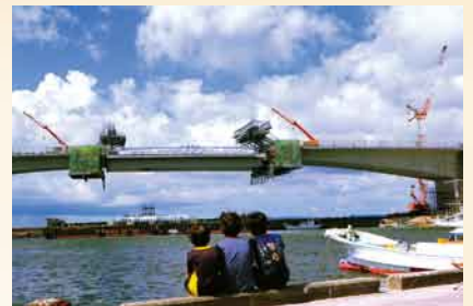
仕事部門 仲道幸子 浦添市浦添北道路橋梁工事 未来の青年
