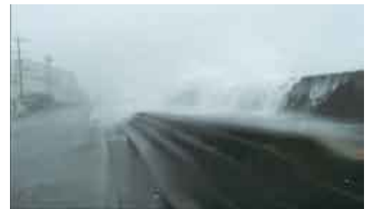
図-2 既存護岸の越波状況:大分港海岸
