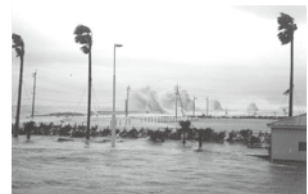
新門司北地区の被災状況(H11.9月 台風18号)
