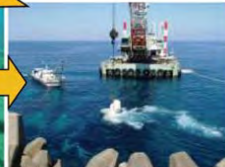
写真-6 ④消波ブロック据付状況
