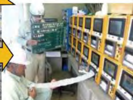
写真-10 ④管理装置による薬液注入量確認
