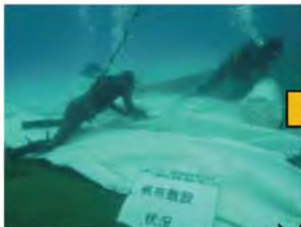
写真-3 ①帆布敷設状況
