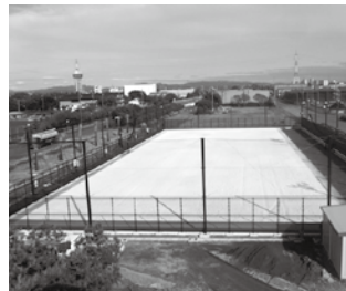
整備中のビーチコート
