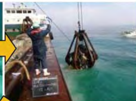
写真-4 ②捨石投入状況
