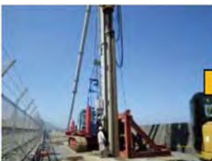
写真-7 ①鋼矢板の打込み状況
