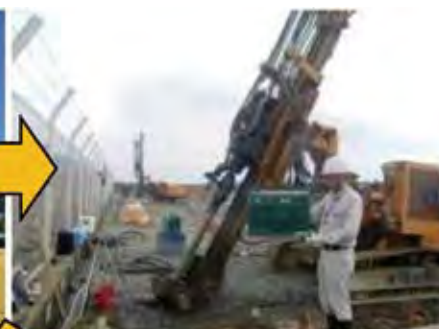
写真-8 ②薬液注入用管の削孔状況
