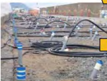
写真-9 ③削孔部からの薬液注入状況
