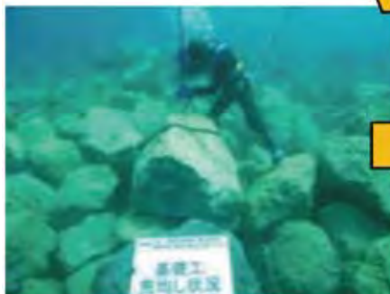
写真-5 ③捨石均し状況
