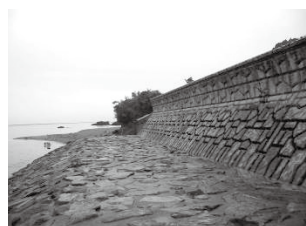
景観に配慮した護岸
