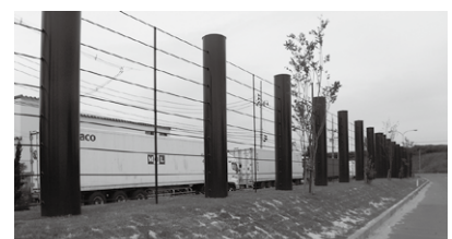
津波漂流物対策施設(設置完了箇所)
