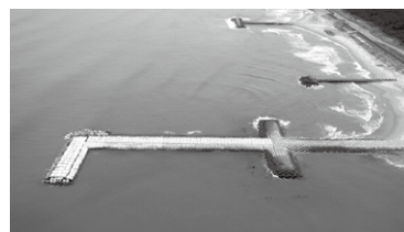
整備中の聖籠海岸の突堤
