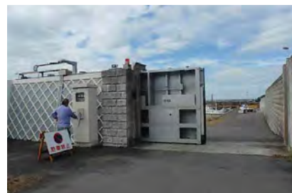
静岡県 土肥港(大藪1号陸閘)
