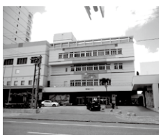
平良港マリンターミナルビル
