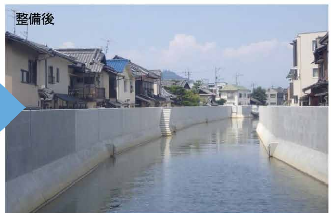
写真-12 宮下川工区の整備後
