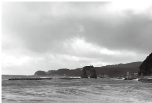
奥尻港海岸の整備(離岸堤・護岸)
