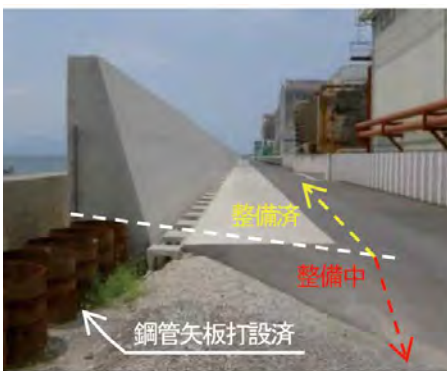
写真-3 観音工区の整備中状況
