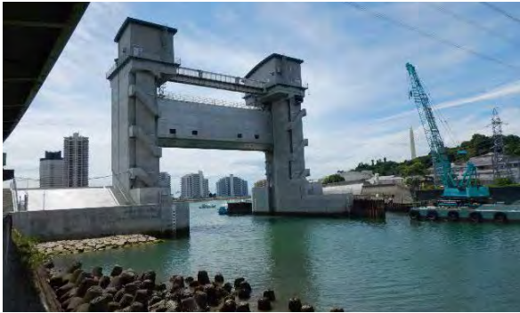
図-2 水門の整備により市街地への浸水を防護:和歌山下津港海岸
