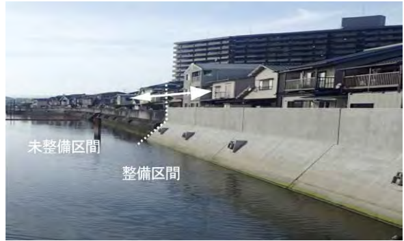
図-3 護岸の嵩上げにより背後の市街地を防護:広島港海岸
