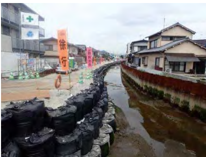
写真-11 仮設道路の設置状況
