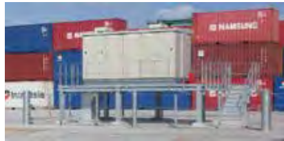
写真-1 電気系設備の嵩上げ事例
