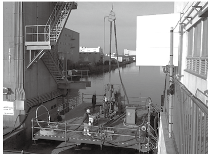
高圧噴射攪拌工(二重管工法)の様子
