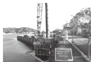
整備状況(新田町地区)
