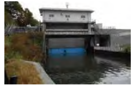
図5 水門閉鎖状況(岩手県宮古市)
