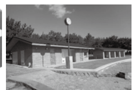
高砂海浜公園 トイレ・休憩所リニューアル
