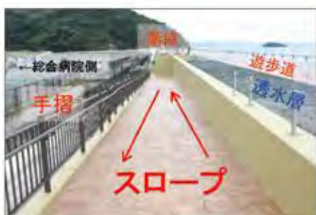
写真-8 スロープ・手摺りの設置
