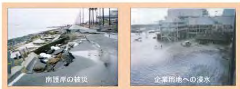
写真-10 平成11年台風18号による被災・浸水状況
