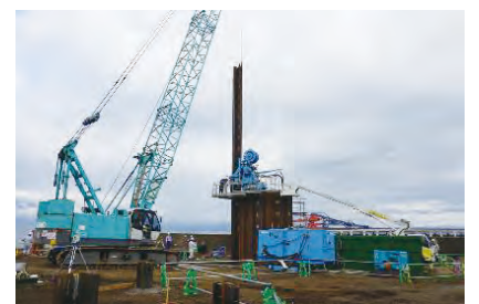
図-7 緊急対策での耐震化状況 (大分港海岸)
