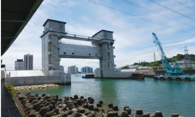
図-2 市街地への浸水を防護する水門 (和歌山下津港海岸)
