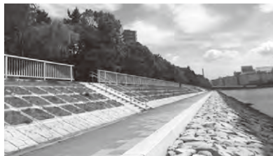
整備完了した京浜運河防潮堤(緩傾斜型による耐震化)
