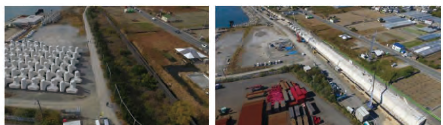
写真-1 新港区間(左:着手前、右:着手後)
