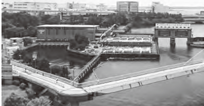
整備中の辰巳排水機場
