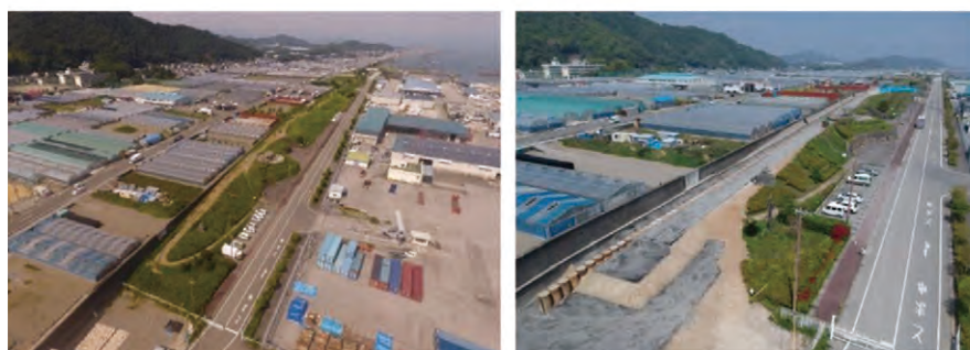
写真-2 緑地区間(左:着手前、右:着手後)
