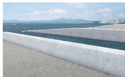
【通常の導流堤上部工】
