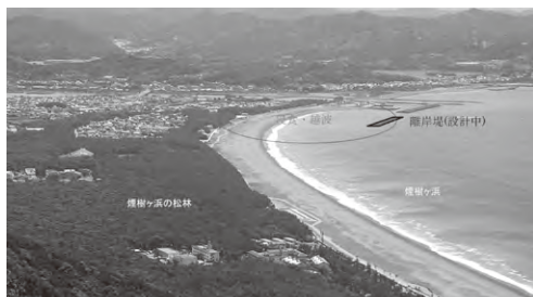
日高港海岸(浜ノ瀬地区)
