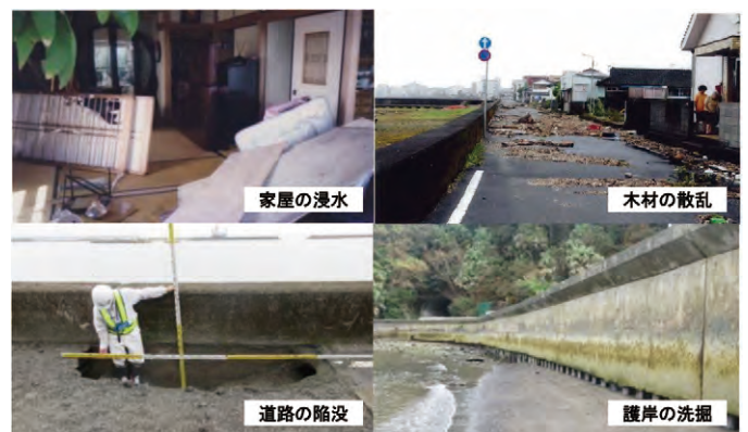
図-4 台風時の高波による被害の状況
