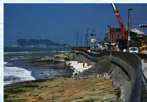
●片山和澄 歩道陥没修復工事
