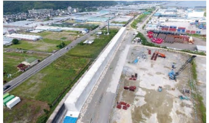
図-3 津波から背後地域を守る堤防 (高知港海岸)
