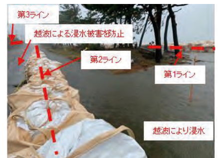
図—6 土嚢を3列に配置し浸水を防止
