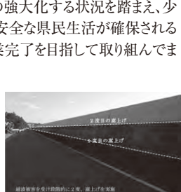
背後護岸の高上げ状況
