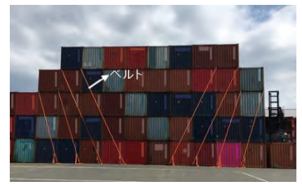
図一九 コンテナ固縛事例
