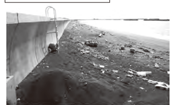
護岸・離岸堤の整備により、侵食が見られなくなっている。
