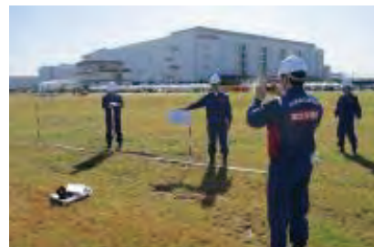
TEC-FORCE隊員による基幹的広域防災拠点被災状況調査
