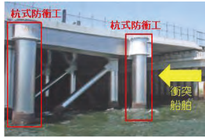
図一八 防衝工設置事例
