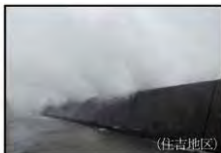
写真-2 越波状況
