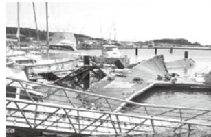
津波による被災状況(銚子マリーナ)
