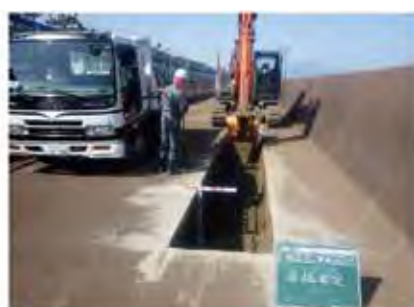
写真-5 溝堀状況
