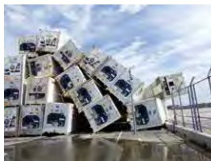
横浜港本牧ふ頭の空コンテナ、SOLASフェンス倒壊(令和元年台風15号)
