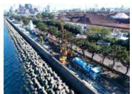
写真-6 地盤改良状況
