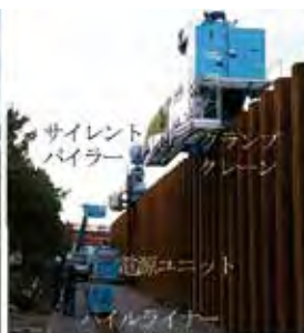
写真-8 打設状況
