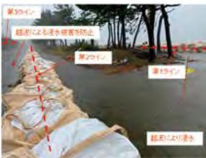
写真-2 土のうの3列配置による浸水被害の防止
