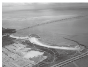
人工ビーチと伊良部大橋
