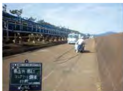
写真-4 水叩き撤去状況
