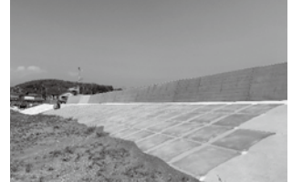
完成した堤防(小畑川河口部)
