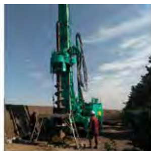
写真-7 削孔状況
