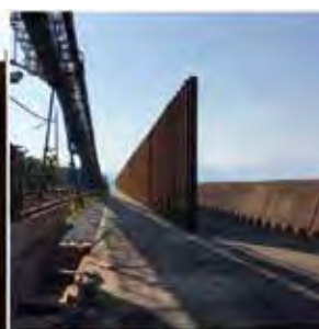
写真-9 打設完了
