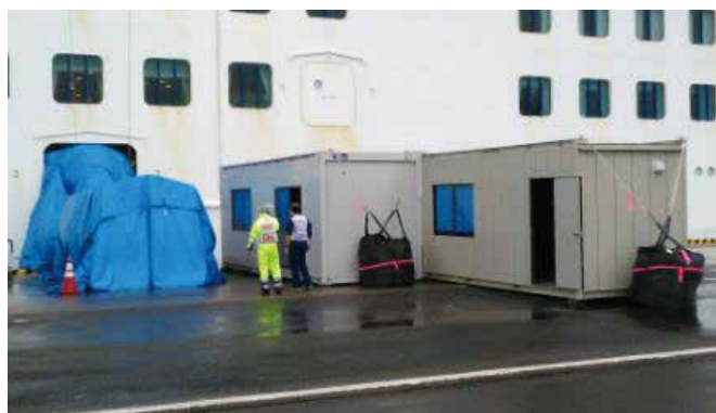
仮設施設の設置
