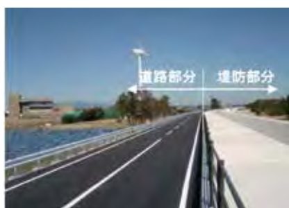
写真-9 都市計画道路と堤防との一連施工完了状況(栗真町屋2工区)
