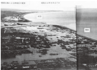
写真-1 伊勢湾台風(S34)によって水没した様子
