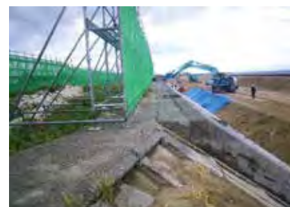
写真-10 栗真工区の現地着手状況
