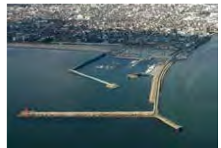
写真-6 セーリング競技会場「津ヨットハーバー」
