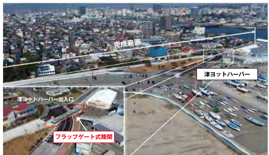
図-5 津ヨットハーバー付近(フラップゲート式陸間含む)完成状況
