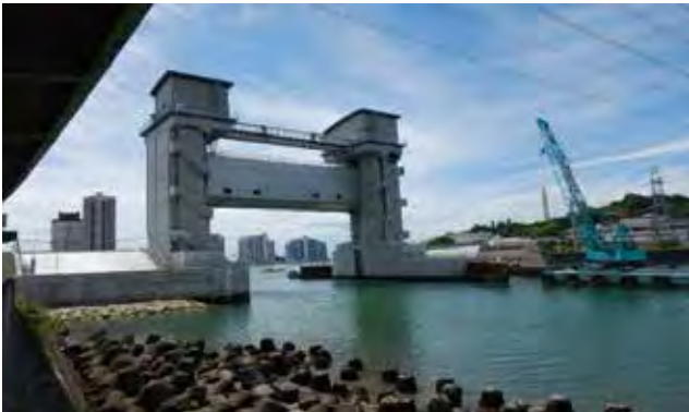
図-2 津波から市街地を防護する水門 (和歌山下津港海岸)
