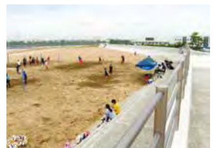
写真-7 ビーチバレーボール競技会場 付近完成状況
