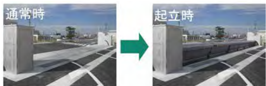
写真-8 フラップゲート式陸間動作(通常時、起立時)状況
