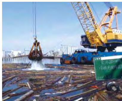
図1. 東日本大震災時の航路啓開の様子
