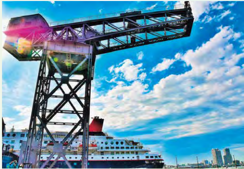
間瀬幾雄 聳えるクレーン
