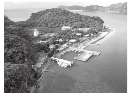
船浮地区 全景
