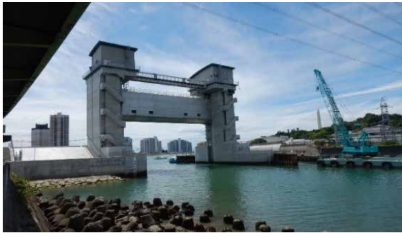
図-2 津波から市街地を防護する水門 (和歌山下津港海岸)
