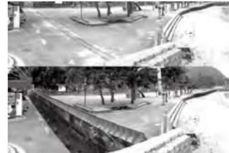
起伏式ゲート(上:開放時 下:閉鎖時)
