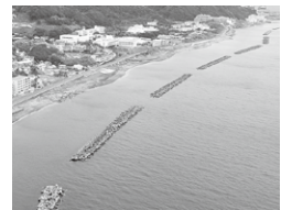
離岸堤とトンボロ現象
