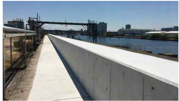
図-3 高潮から背後地域を守る護岸 (名古屋港海岸)
