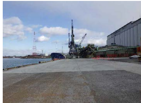
中央ふ頭1・2号岸壁 復旧完了
