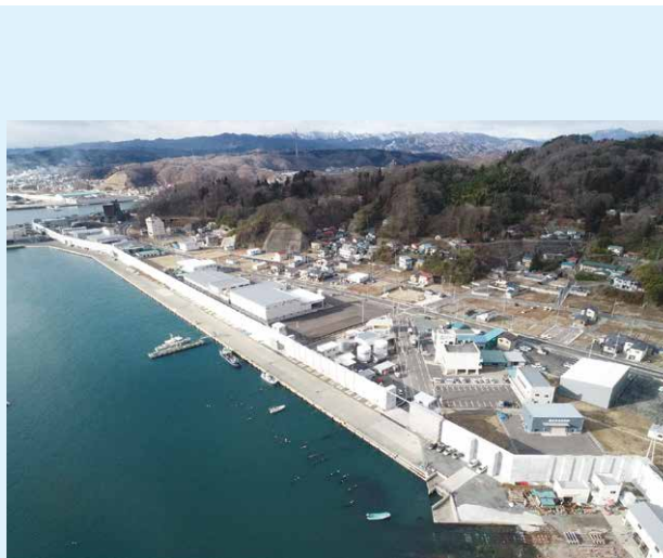
宮古港鉾ヶ崎防潮堤
