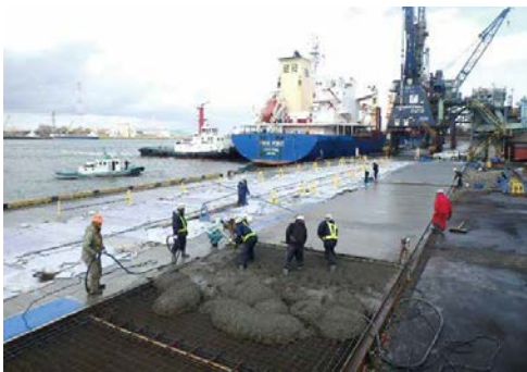
中央南ふ頭1・2号岸壁 コンクリート舗装打設
