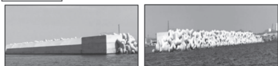
上部工の嵩上げ
