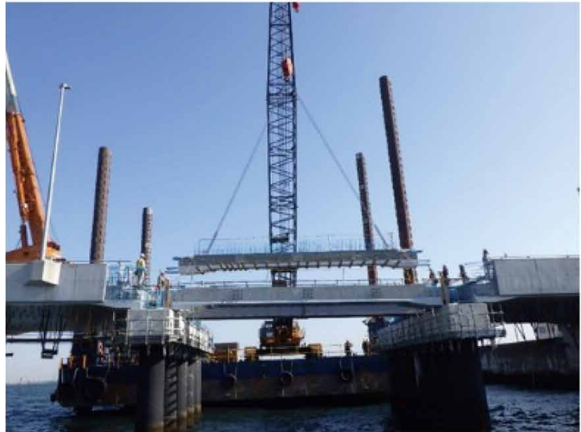
写真-6 PC桁架設状況
