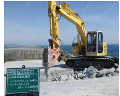
写真5 上部工破砕状況
