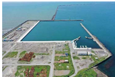
船だまり 復旧完了
