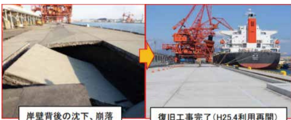
7号ふ頭の岸壁の復旧状況
