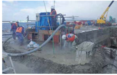
写真8 高圧噴射攪拌工法の状況
