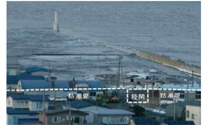
東北地方太平洋沖地震の津波（平成23年3月11日）
