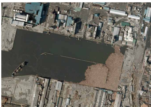
飼料等専用岸壁における護岸損壊、木材流出
