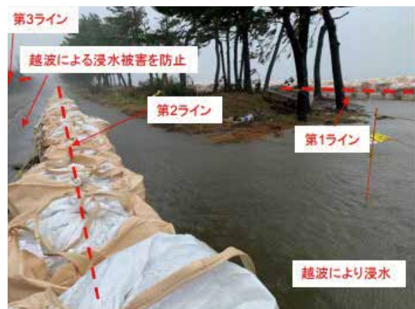
土のうを3列に配置し、浸水被害を防止
