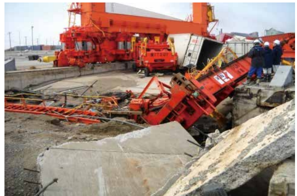
高砂コンテナターミナルにおける運搬機械の漂流・損壊
