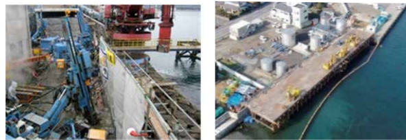
図-4 狭隘箇所・石油タンク付近での地盤改良
