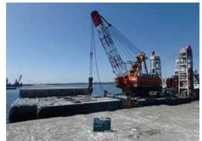
写真6 ケーソン破砕状況
