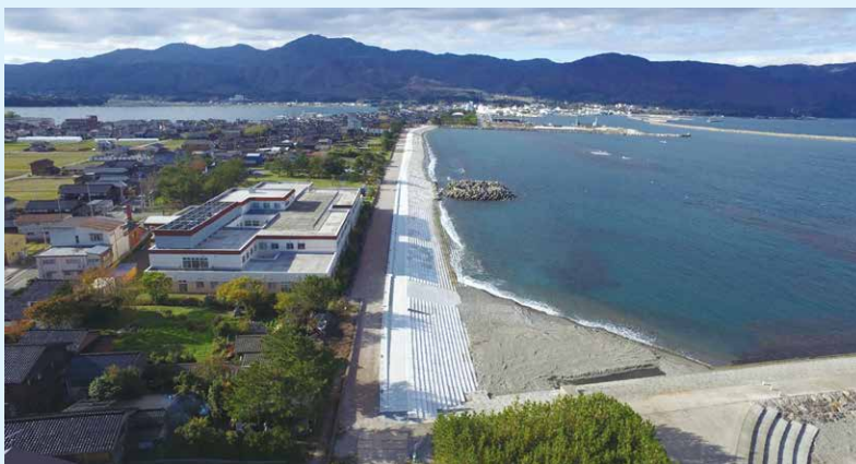
離岸堤(潜堤)と 緩傾斜護岸を組み合わせた 面的防護方式による整備
