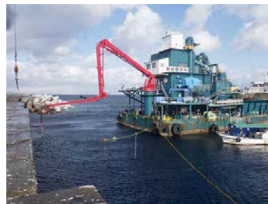
写真10 水中不分離性コンクリート打設状況
