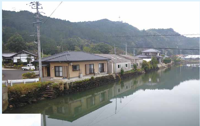
七ツ釜海岸高潮事業(施工前)
