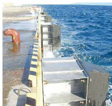
写真-5 防舷材用鋼製台座
