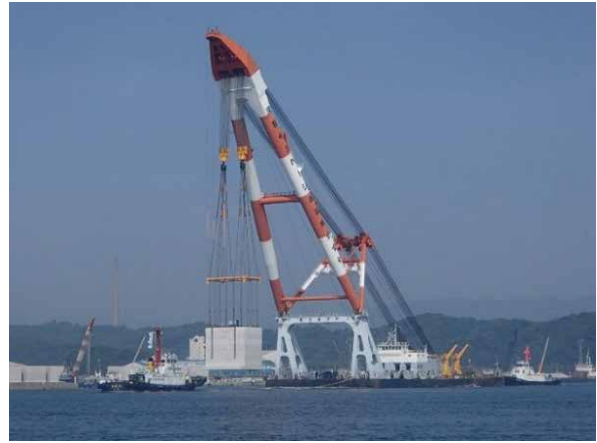
ケーソンをつり上げ据付場所まで移動する起重機船
