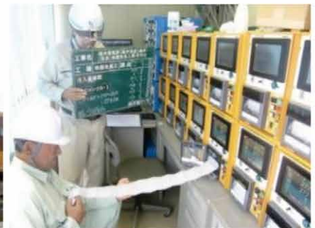
写真-6 管理装置による薬液注入量確認
