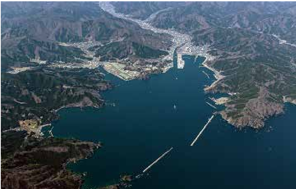
釜石港の航空写真
