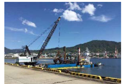
泊地に堆積した土砂を撤去する様子
