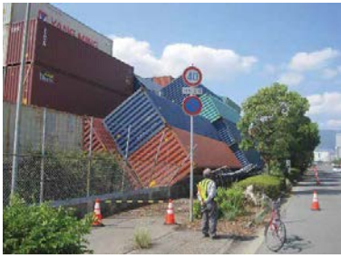
写真-6 港湾保安施設被災状況
