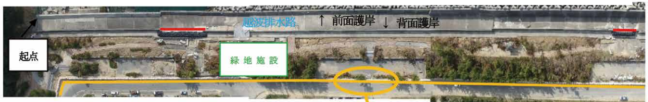
写真-2 【被災後】第2防護ライン構築後(平成30年10月22日撮影) ※ 写真上: 海側、写真下: 工業団地側
