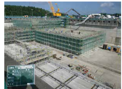
写真7 ケーソン製作状況
