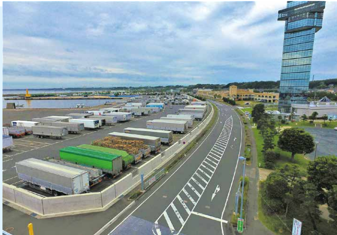
港湾背後を守る防潮堤の整備状況
