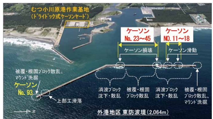
写真2 東防波堤の被災概要
