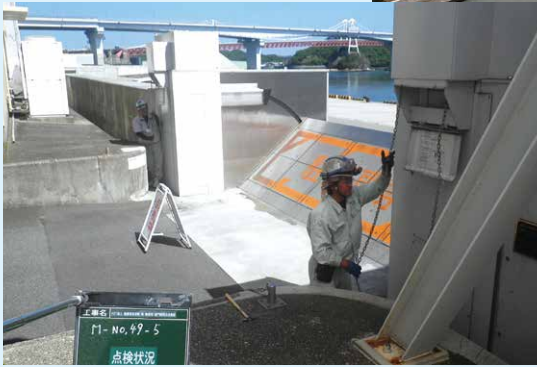
フラップゲート(浮体式防潮堤)の 定期点検
