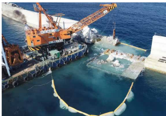
砕岩棒によるケーソン取り壊し状況
