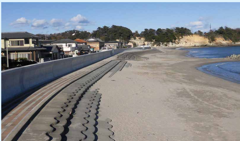
背後の住宅地を守る防潮堤
