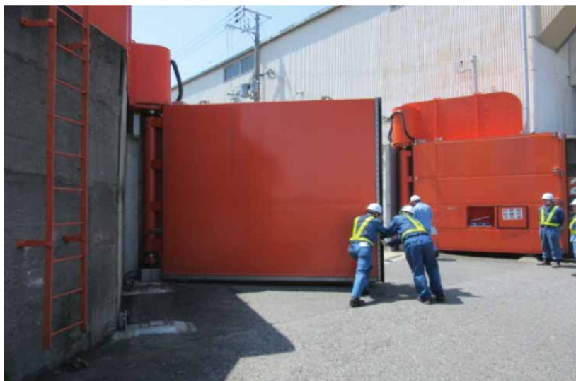
平常時の陸閘の点検・訓練の様子（大阪港海岸）
