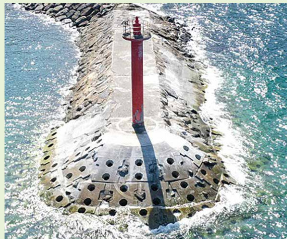
細木航路復旧後
