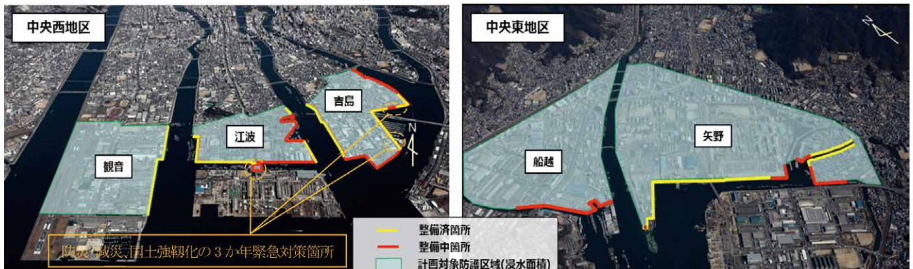
図-3 広島港海岸直轄海岸保全施設整備状況 (令和元年度時点)
