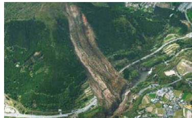
大規模な斜面放火による 道路（国道）寸断と落橋
