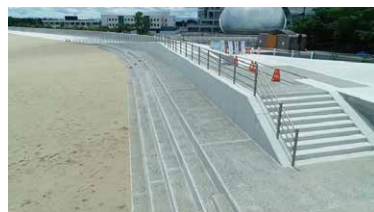
写真-4 階段護岸(阿漕浦・御殿場工区)
