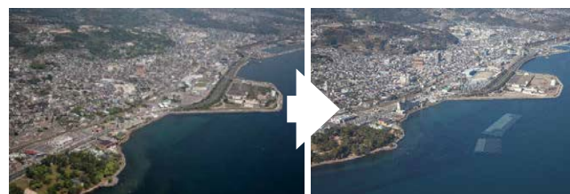
写真-11 上人ヶ浜地区の整備前と整備後
