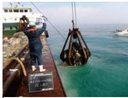
写真-3 捨石投入状況
