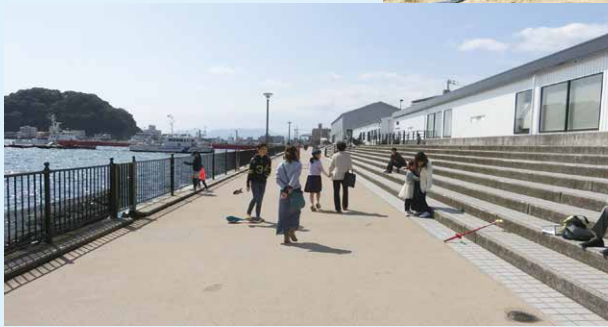
宇品デポルトピア 階段式胸壁
