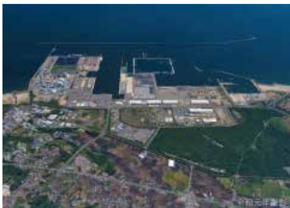
茨城港常陸那珂港区の航空写真
