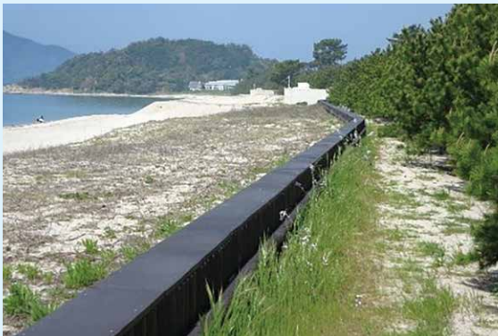
松林前面に景観に配慮した胸壁を整備
