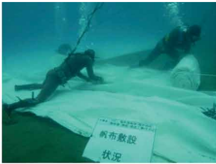
写真-2 帆布敷設状況
