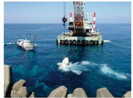
写真-4 消波ブロック据付状況
