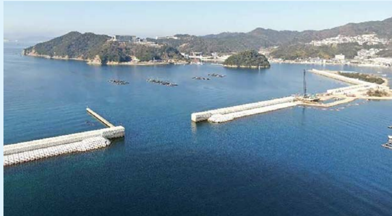
湾口防波堤の整備 (津波対策:施工中)
