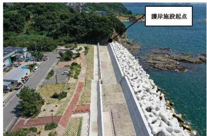
写真-4 工事完成後
