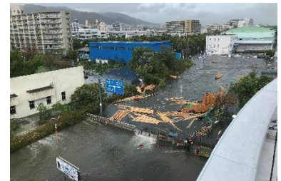
写真-4 魚崎地区浸水状況
