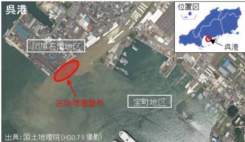
河川から港内への土砂流出状況
