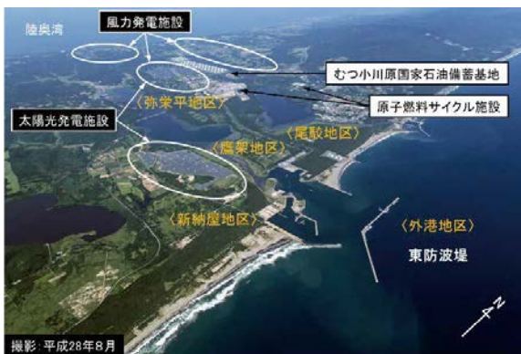
写真1 むつ小川原港全景
