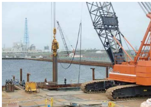
船だまり4m物揚場 矢板打設
