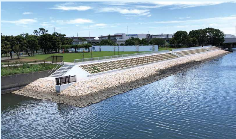
自然環境や利用面に配慮した 緩傾斜型防潮堤
