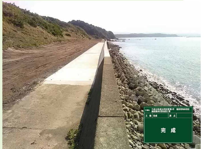
復旧した波返工の全景
