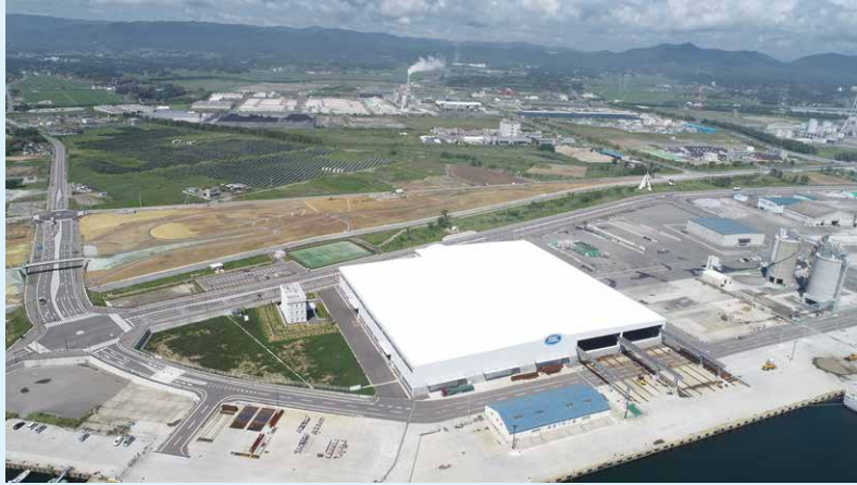
原釜堤防全景写真
