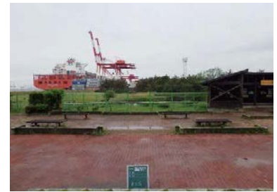
写真-10 六甲マリンパーク復旧前
