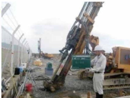
写真-5 薬液注入用管の削孔状況
