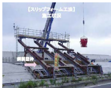
写真1：堤防施工状況
