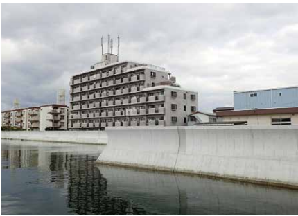
写真-2 江波工区(整備後)
