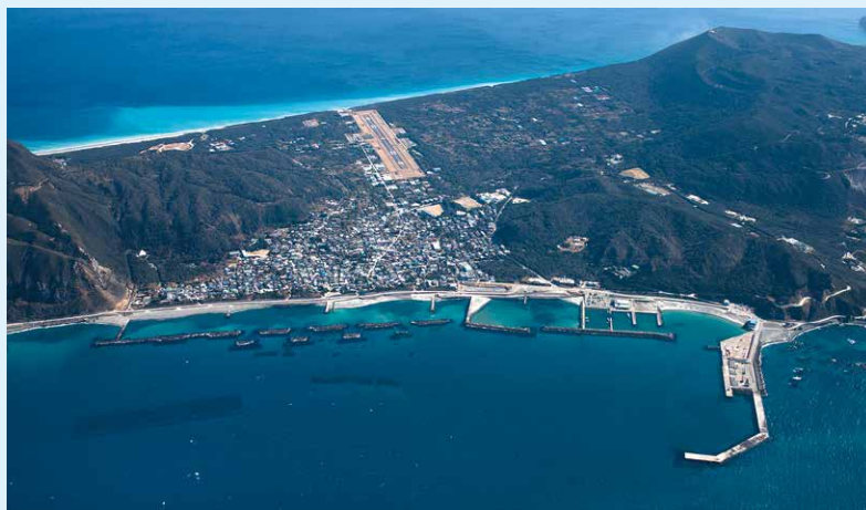
侵食対策のための 離岸堤
