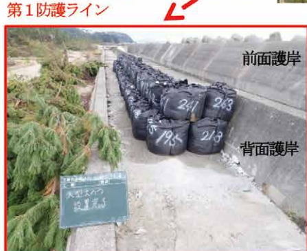
背面護岸倒壊箇所に設置した大型土のう
