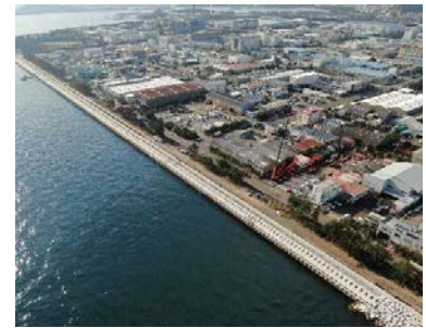
写真5 福浦地区護岸の現状（令和2年11月時点）
