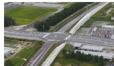
写真2：乗越道路全景
