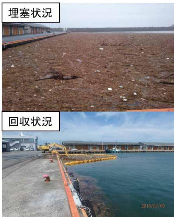
鳥取港における埋塞状況・回収状況
