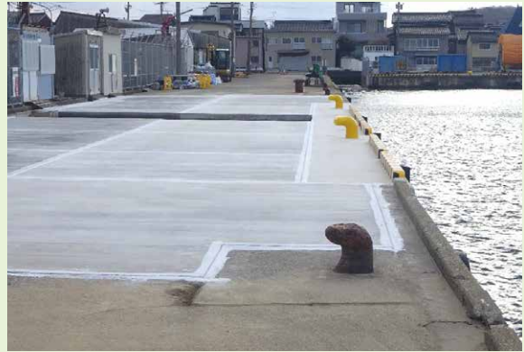
国分1号岸壁復旧工事完成状況
