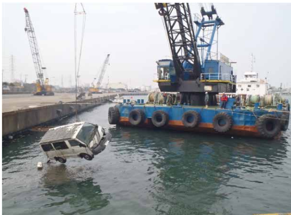
障害物除去の様子
