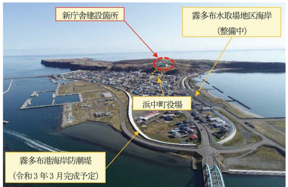
防潮堤に囲まれた霧多布港海岸 (令和2年11月)
