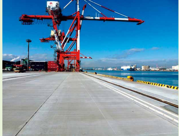
高砂ふ頭1号岸壁(復旧後)
