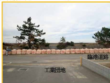
背面護岸倒壊箇所の陸側に設置した大型土のう
