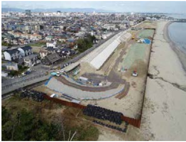
写真-1 工事の状況(阿漕浦・御殿場工区)
