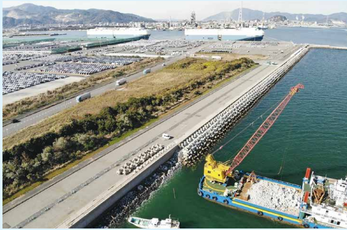
苅田港海岸 (整備中)
