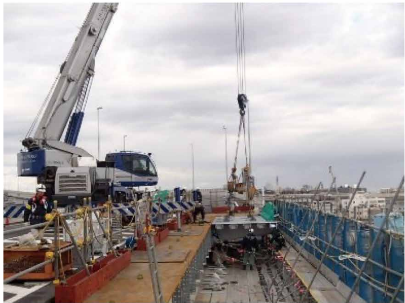
写真-7 鋼床版架設状況
