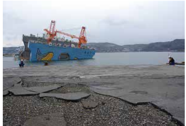
津波で被災し傾いたフローティングドッグ
