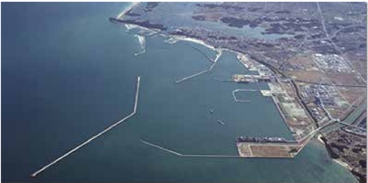
相馬港の被害状況
