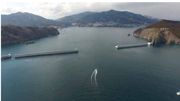
復旧した湾口防波堤
