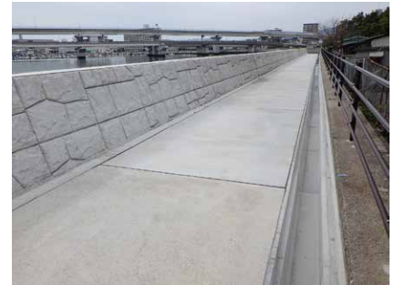
写真-3 吉島工区(整備後)
