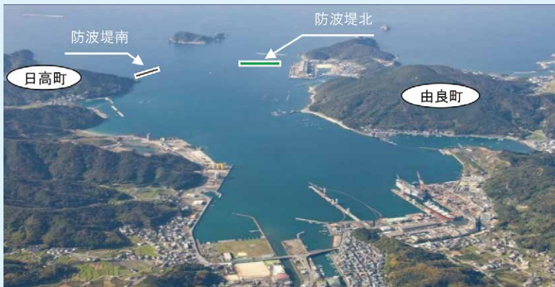
防波堤南 R2.6月完成
