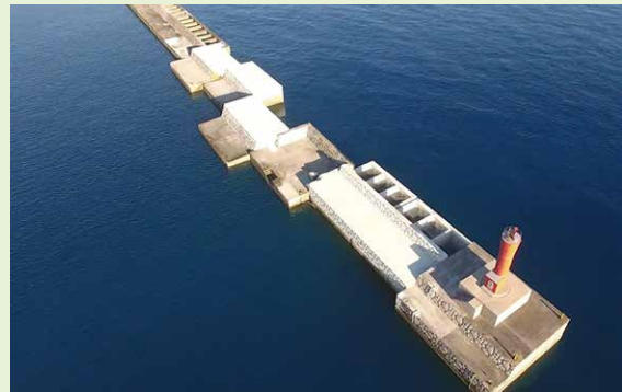
復旧完成(新たに造り直しと補強した復旧箇所)
