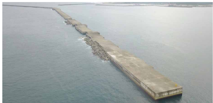
写真11 復旧完成全景
