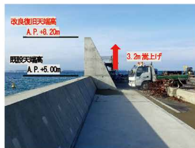
写真-5 施工状況
