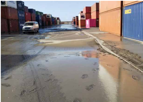
コンテナ埠頭の液状化
