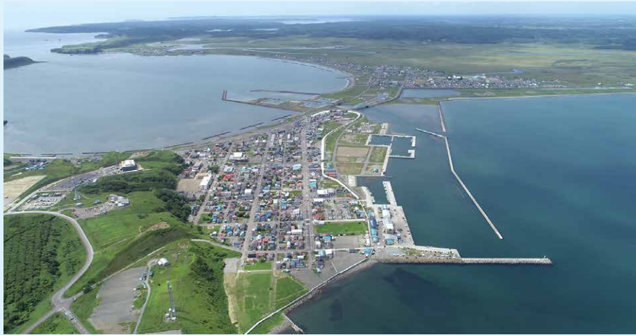
嵩上げ改良後の防潮堤に防護された浜中町市街地
