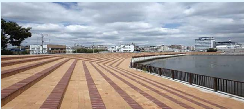
大阪府堺市堺区堺旧港地区 護岸改良(防潮堤の液状化対策)
