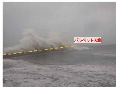
写真-3 越波状況
