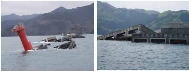
湾口防波堤の被災状況
