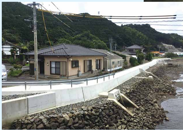
七ツ釜海岸高潮事業(施工後)
