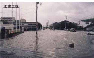
写真-1 平成16年台風による浸水状況
