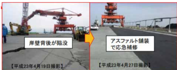
5号ふ頭の岸壁の復旧状況
