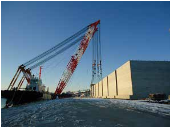
国内最大級の起重機船でのケーソンのつり上げ
