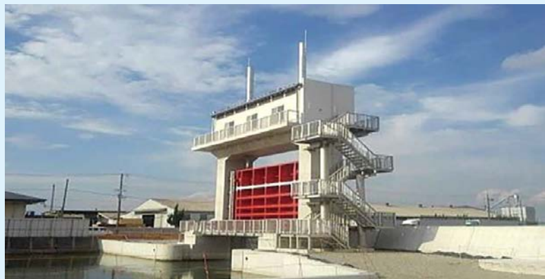
大阪府泉北郡忠岡町忠岡 岸和田地区 北水門の改良(水門更新)
