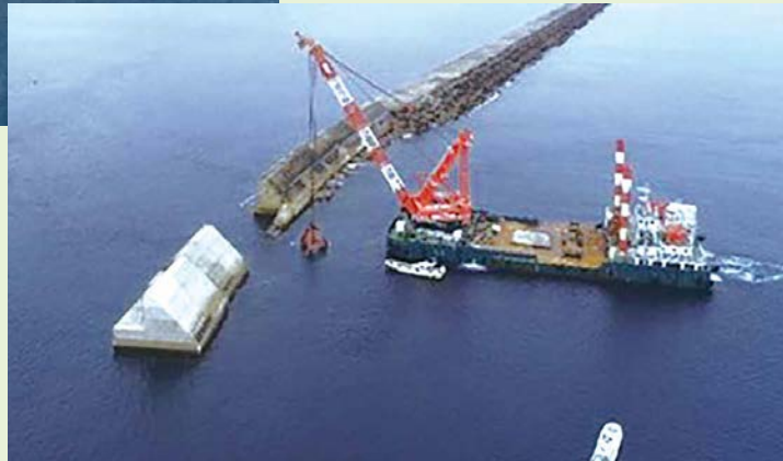
復旧状況:令和2年4月
