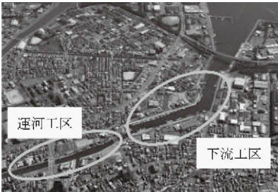
衣浦港海岸(半田地区) 半田市
