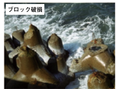
＜老朽化の進行による海岸保全施設の破損・損傷例＞
