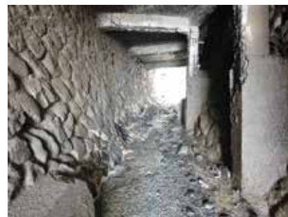
写真10 暗渠内の写真 (7/11)
