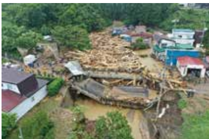
【写真1】落橋した小赤川橋
