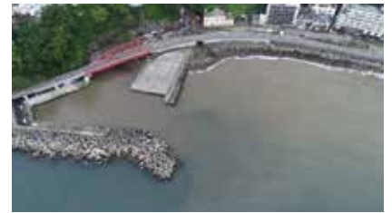
写真5 熱海港伊豆山地区 (7/4)
