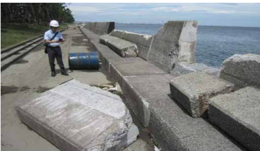
図2 神奈川県横浜市の高波による護岸倒壊（令和元年房総半島台風）
