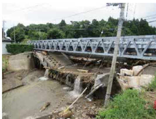
【写真6】直轄により応急復旧された小赤川橋(仮橋)
