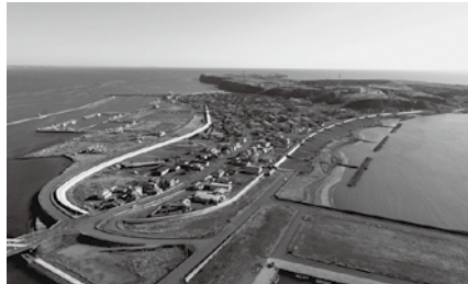
霧多布港海岸防潮堤
