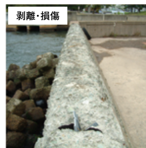
＜老朽化の進行による海岸保全施設の破損・損傷例＞
