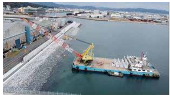
写真-2 タイヤ工場の護岸改良状況
