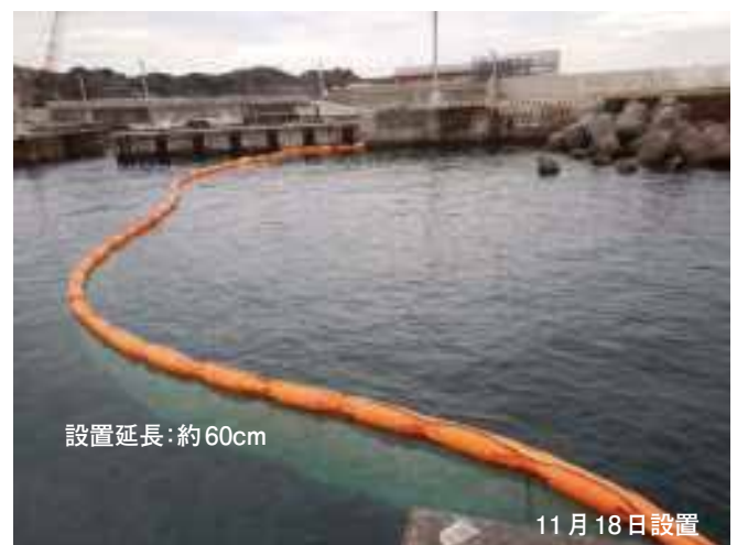
オイルフェンス設置状況(神津島港)
