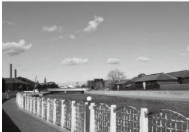
運河工区(石積護岸と黒蔵、手前は遊歩道)
