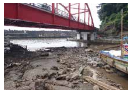
写真6 船揚場に堆積した土砂 (7/13)
