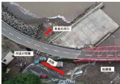
写真4 逢初川下流部 (7/4)
