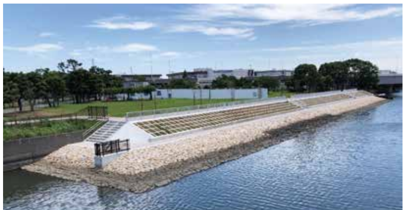
緩傾斜型護岸整備事例(平和島運河)
