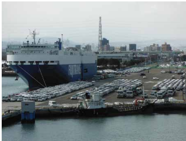
＜完成自動車の荷役状況（仙台塩釜港）＞
