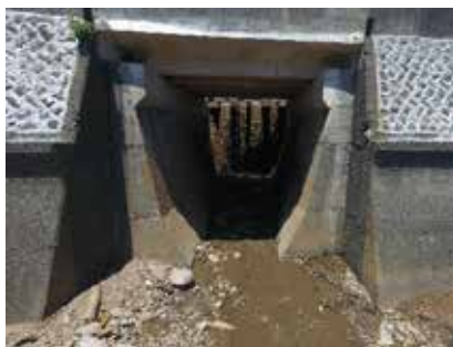
写真9 下流部の暗渠(下流側より) (7/4)
