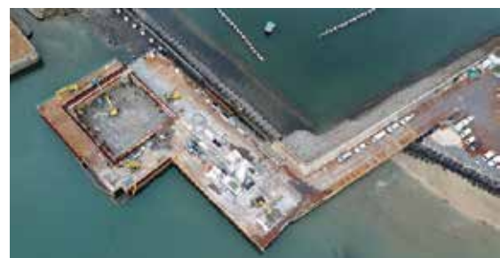
写真-3 新川水門 施工状況
