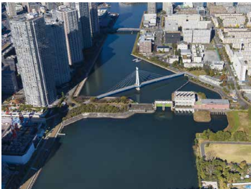
東京港における海岸保全施設(辰巳運河)
