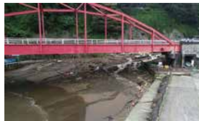
(熱海港の崩落土砂の堆積)
