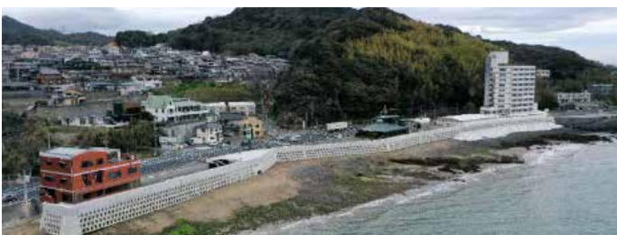
写真-1 浜浦工区 護岸改良完成
