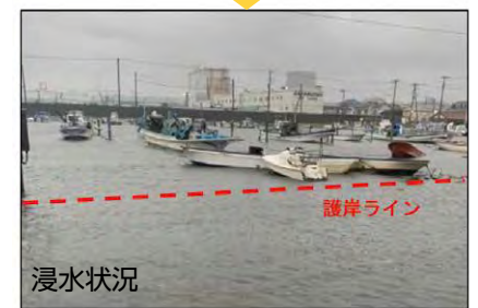
写真3 高潮被害(令和元年房総半島台風)
