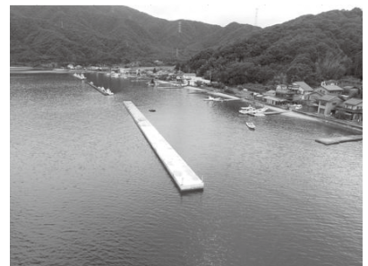
縄間地区 3号離岸堤完成
