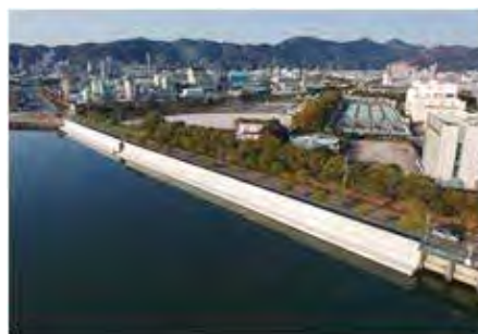
写真-2 新田町工区
