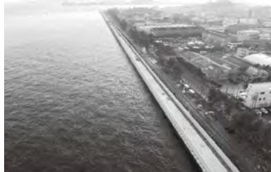
金沢エリアの復旧状況
