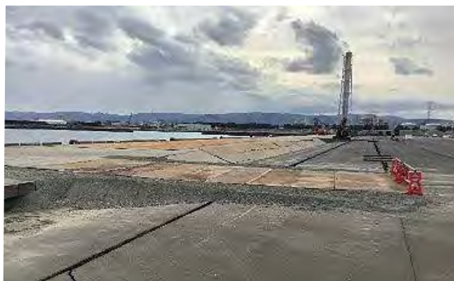
【写真7】応急復旧完了 (3号ふ頭)
