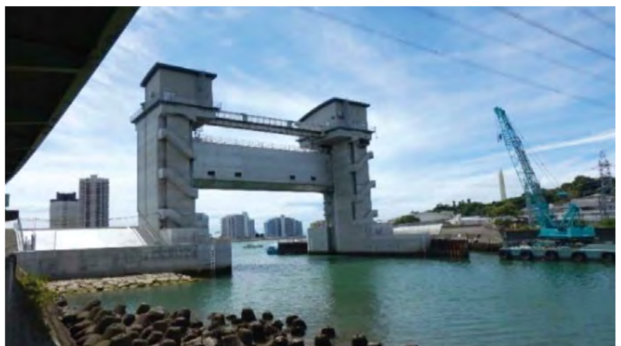
図表 8 津波から市街地を防護する水門(和歌山下津港海岸)
