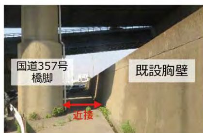
写真7 橋脚近接状況(事業所)
