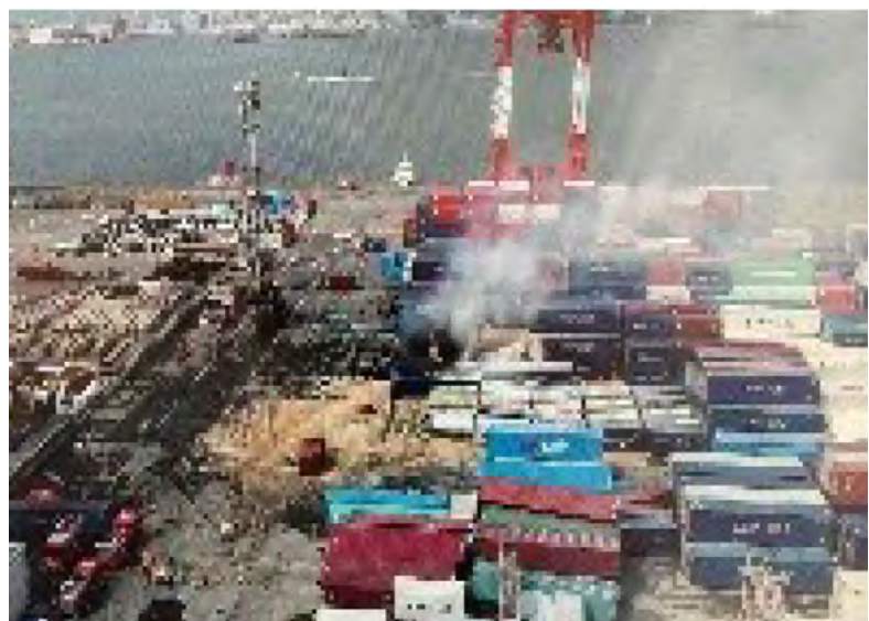
図表1 平成30年台風第21号による高潮浸水で火災が発生したコンテナターミナル（神戸港）
