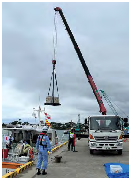
浜名港岸壁での緊急支援物資の荷揚げ
