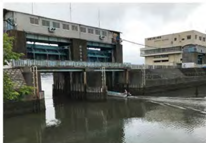
写真8 海老川水門稼働状況
