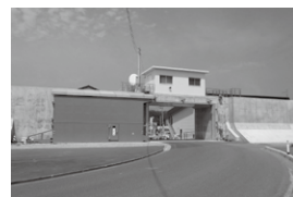
写真2 神林3号陸閘(宮古市)
