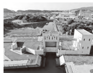
瀬上川津波水門
