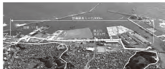
日立港区海岸全景
