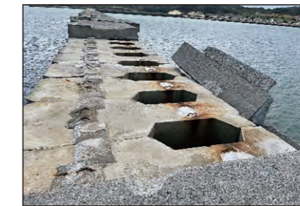
写真-3 守江港納屋地区防波堤(南)
