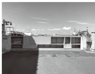
仙台塩釜港 塩釜港区の陸閘
