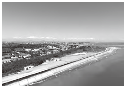
宇治山田港海岸(二見地区)堤防工
