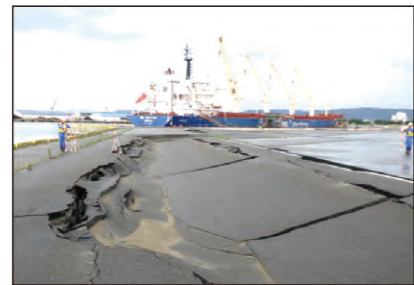
写真-1 相馬港3号ふ頭地区護岸
