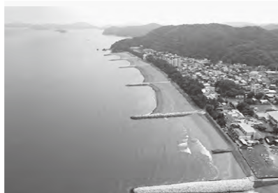
宇治山田港海岸(二見地区)突堤工・養浜工
