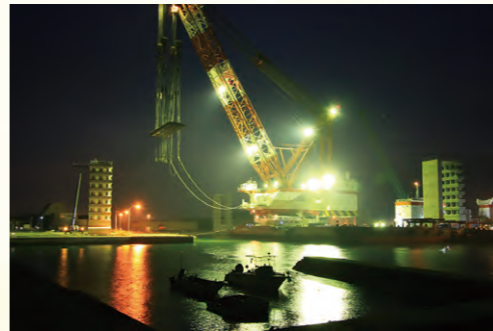
◎横山彰 ケーソン吊り上げ
