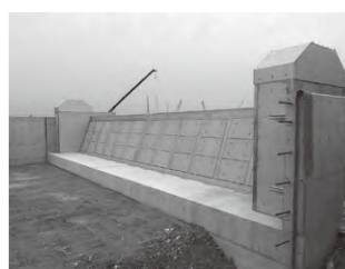
フラップゲート式陸閘(起伏:作動試験時)
