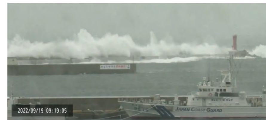
図5 令和4年台風14号時のみなとカメラからの防波堤の状況
