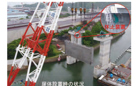
写真-2 扉体設置時の状況
