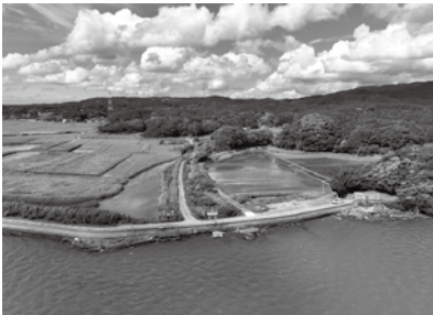
樋門、背後の潮遊びと田園風景
