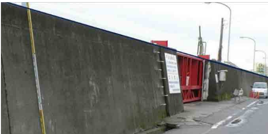
写真5 高潮等から市街地を防護する胸壁 (嵩上げ・耐震化予定) (千葉港海岸)
