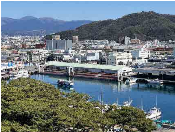
整備中の内港浮さん橋
