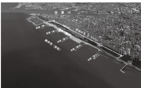
新潟港海岸全景
