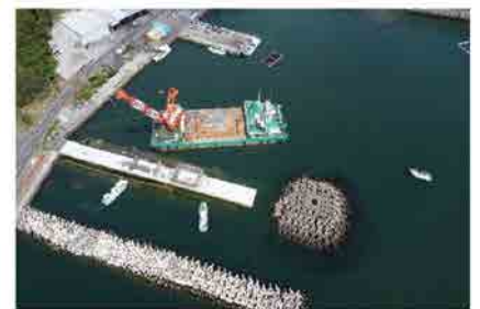
写真-1 古江地区(防波堤施工状況)
