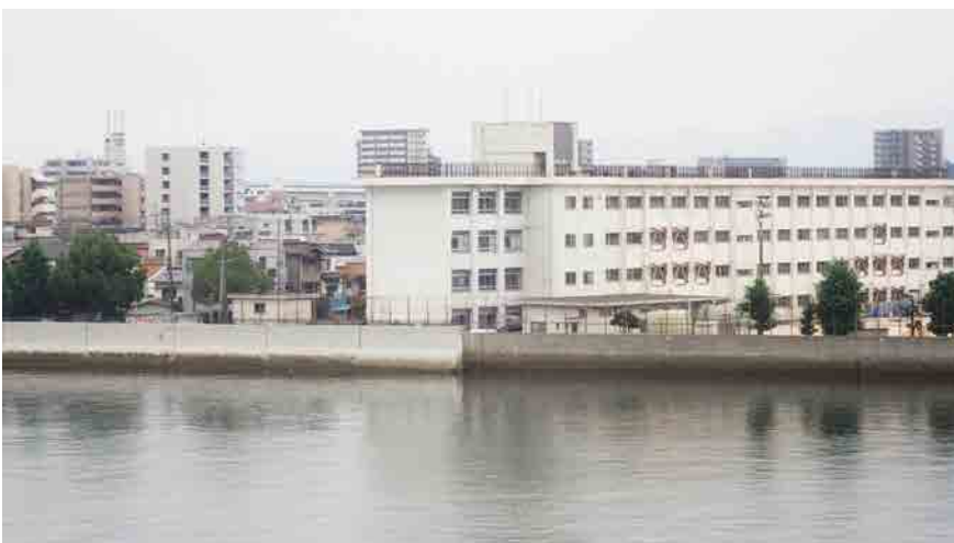
写真6 高潮等から市街地を防護する護岸 (広島港海岸)
