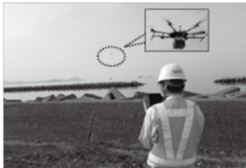
UAV搭載グリーンレーザを活用した点検
