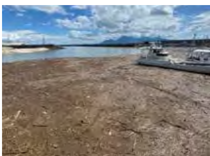
図-7 長洲港泊地の被災状況
