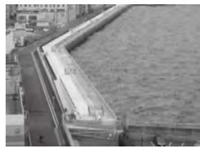
大津地区高潮対策護岸(完成/R5.3)
