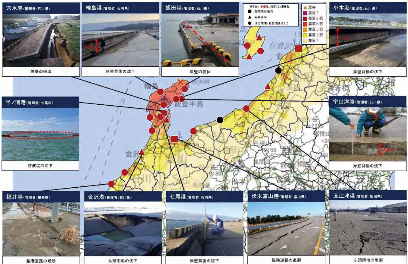
図 - 1 能登半島地震による港湾の被害状況
