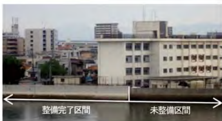
写真-3 吉島工区：護岸の整備状況
