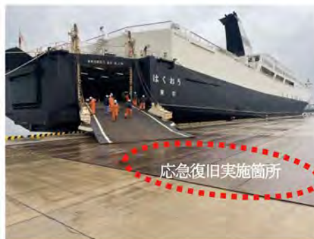
(2) 液状化の影響により、車両が走行できないアクセス経路があったため、応急復旧を実施。防衛省がPFI方式により契約している民間船舶「はくおう」が入港し、被災者支援を実施。（1月14日～）
