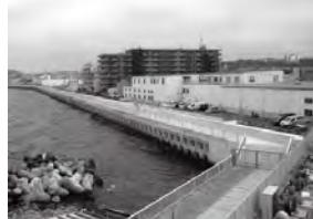
大津地区高潮対策護岸(完成/R5.3)
