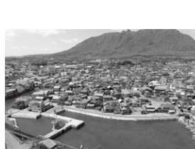
高潮対策完成(令和5年5月)
