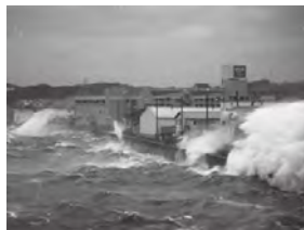
大津地区 整備前(越波状況)
