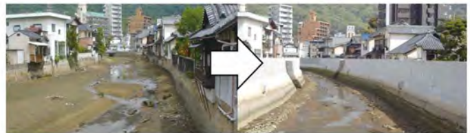
写真-4 矢野工区：護岸の整備状況(左:整備前、右:整備後)
