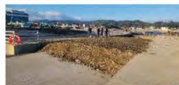
(5) アクセス経路に段差が生じていたため、応急復旧を実施（1月5日）
