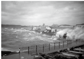
大津地区 整備前(越波状況)
