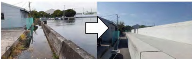
写真-2 江波工区：護岸の整備状況(左:整備前、右:整備後)
