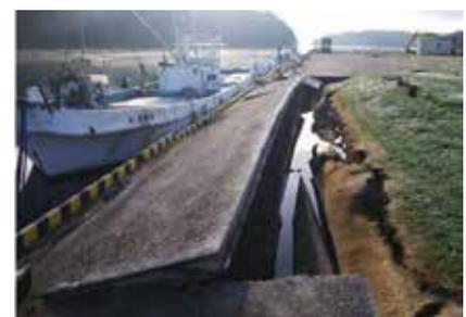
図-7 穴水港 岸壁の被災状況
