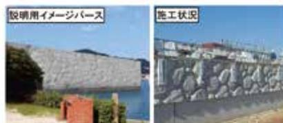
写真-3 巨石積型の化粧型枠
