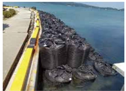
写真6 応急復旧状況② (土のう設置完了)
