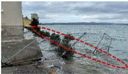
図-9 和倉港 護岸の被災状況
