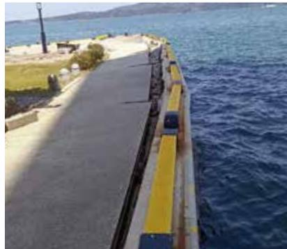
写真1 被災状況① (護岸傾斜)
