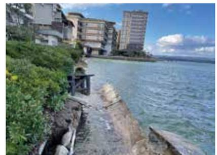
写真4 被災状況④ (護岸崩壊)
