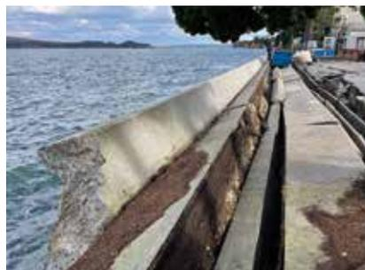
写真3 被災状況③ (護岸崩壊及び傾斜)
