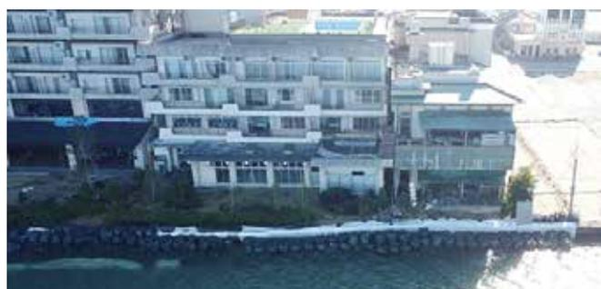
写真7 応急復旧状況③ (土のう設置完了)
