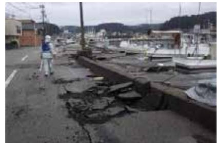
図-6 宇出津港 臨港道路の被災状況
