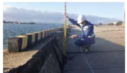
図-4 七尾港 岸壁の被災状況
