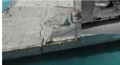
図-12 直江津港 岸壁の被災状況
