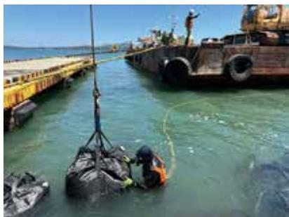
写真5 応急復旧状況① (土のう設置)
