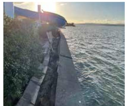
写真2 被災状況② (護岸傾斜)
