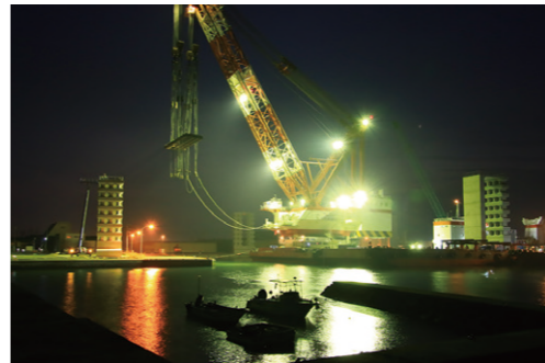
◎横山彰 ケーソン吊り上げ
